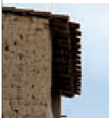
A_b 2 Canale di gronda senza muretto d'attico
