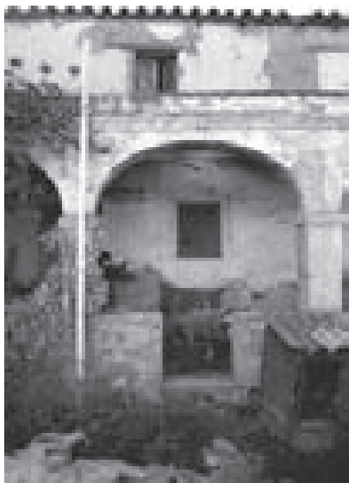
Particolare del loggiato.
