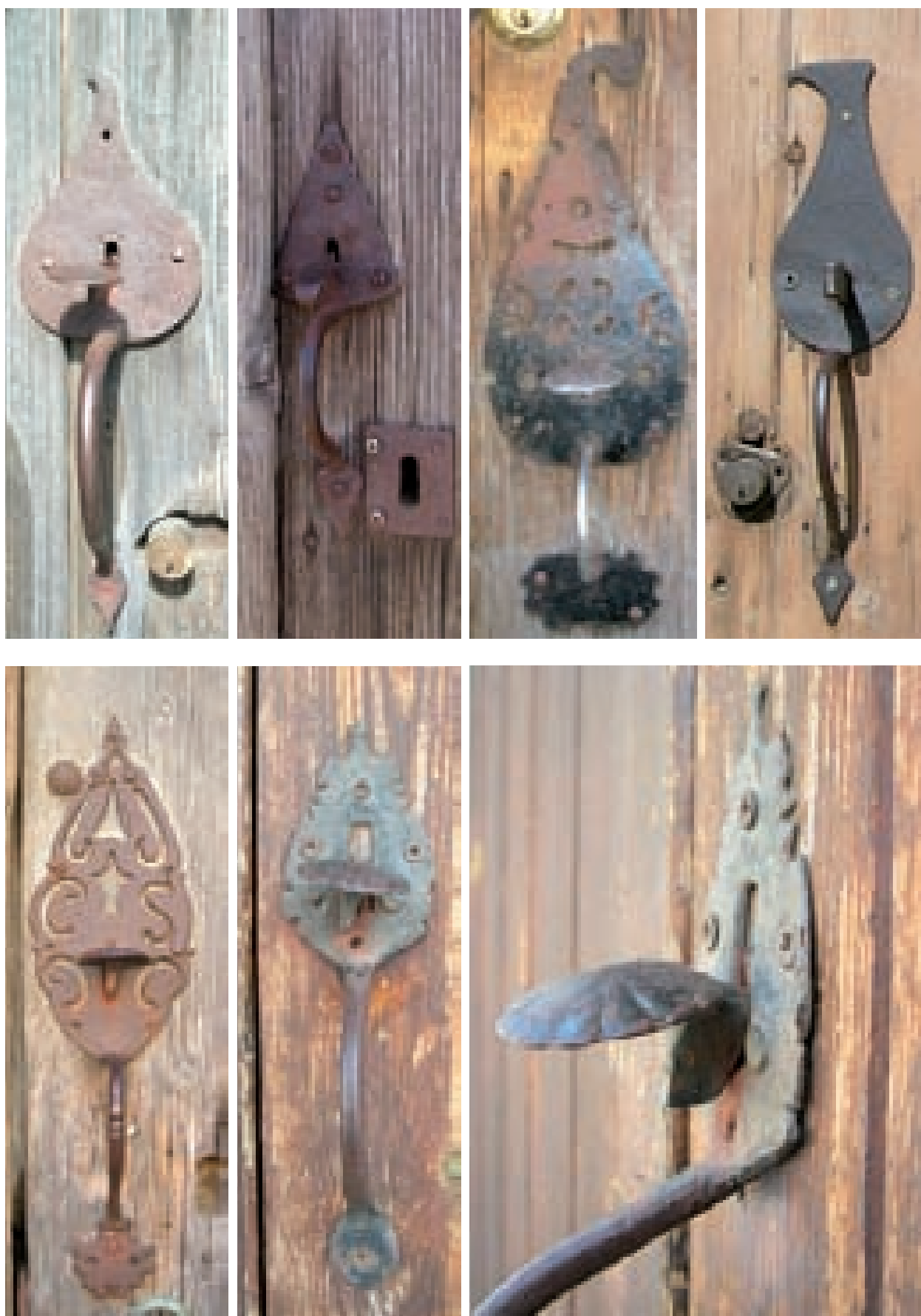
Figg. 3.78 - 3.84. Esempi di ferramenta di apertura delle porte d'ingresso e portali. La parte esterna serve a sollevare il paletto interno ed è inserita in placche decorate, chiodate od avvitate alle tavole. Nella parte inferiore, solitamente, la placca si conclude con una piccola maniglia.
