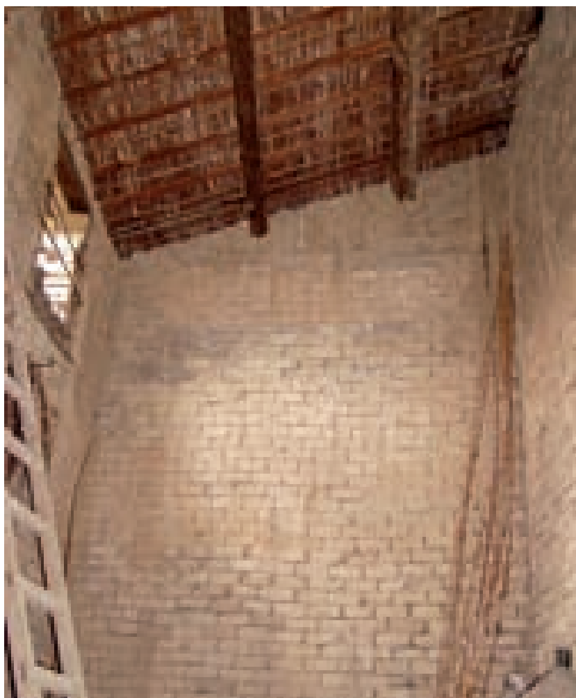
Fig. 4.2. Villamassargia, nel Cixerri. Interno di una casa storico-tradizionale: alla scatola muraria, costituita da spesse murature in terra, si contrappone una copertura sottile e leggera costituita da un orditura lignea con impalcato in canne, massetto in terra stabilizzata con calce e finitura in coppi laterizi.
