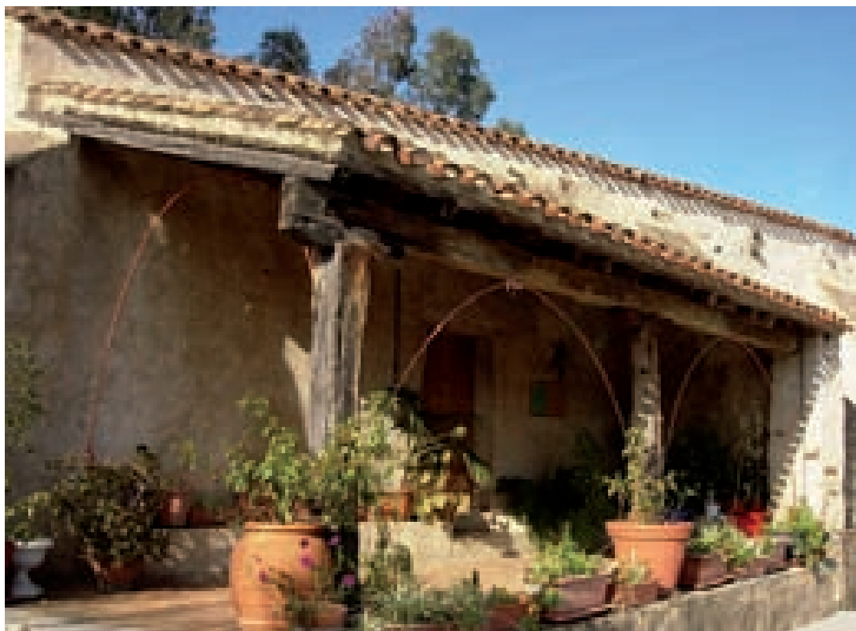
Fig. 3.61. San Vito. Loggiato con pilastri e travi lignei.
