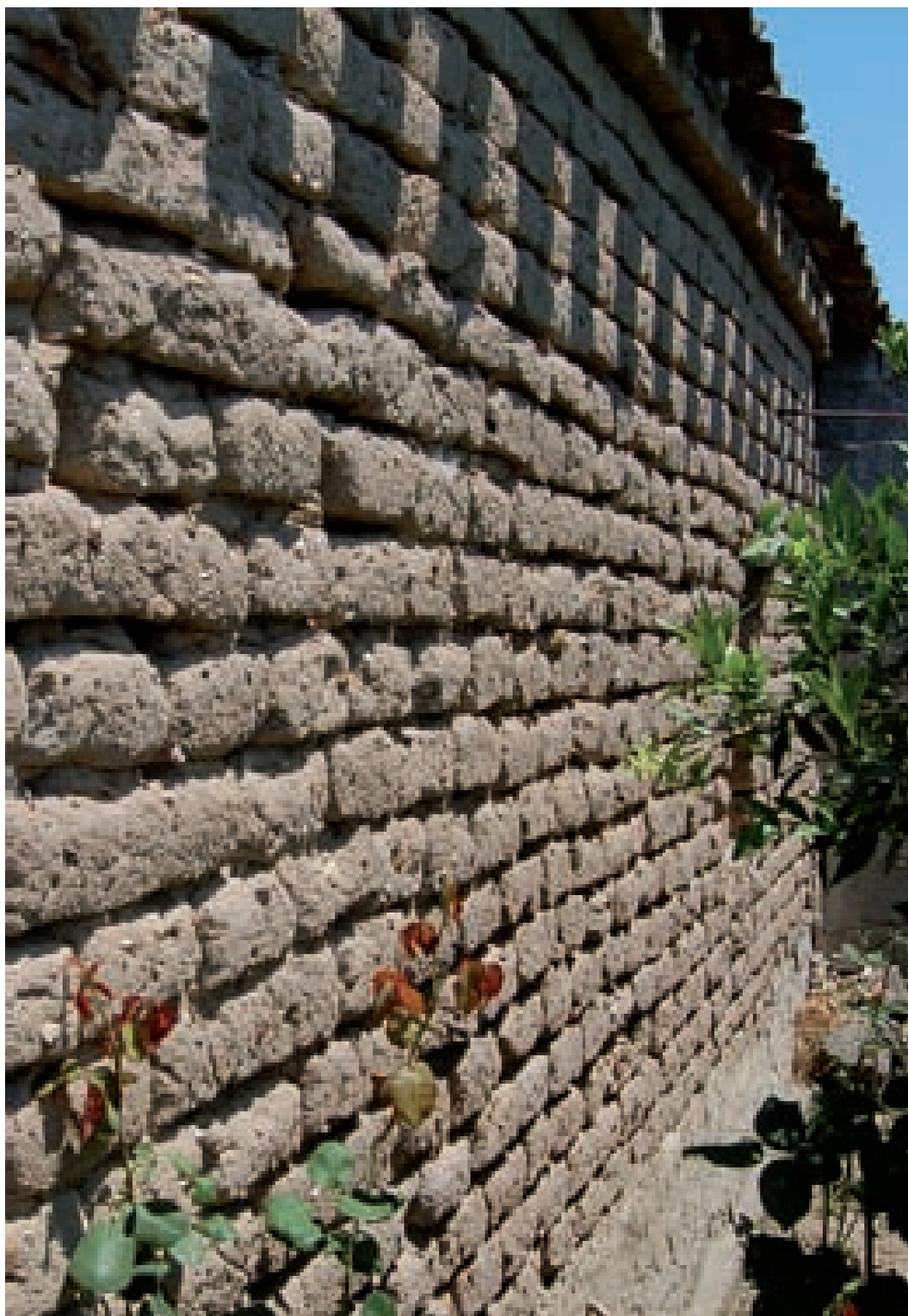
Fig. 3.1. Massama. Muratura in mattoni di terra cruda con apparecchio di punta.
