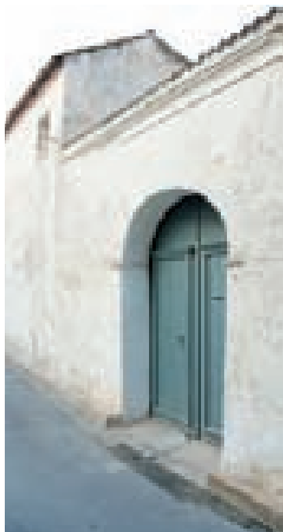
Fig. 2.47. San Vito (Sarrabus). Casa a corte con portale. Anche nel sud-est dell'isola la logica dell'introrsione regola il rapporto fra casa e strada; il muro che separa lo spazio privato da quello pubblico diventa permeabile attraverso il portale.
