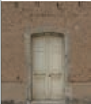
B_b 1 Porta con stipiti e arco ribassato in mattoni crudi con arco di scarico sovrastante in mattoni crudi
