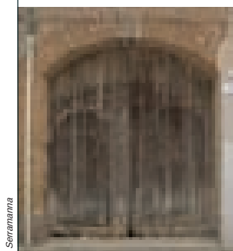
B_b 8 Arco a sesto ribassato con apparecchiatura a due teste in mattoni crudi su stipiti in mattoni crudi
