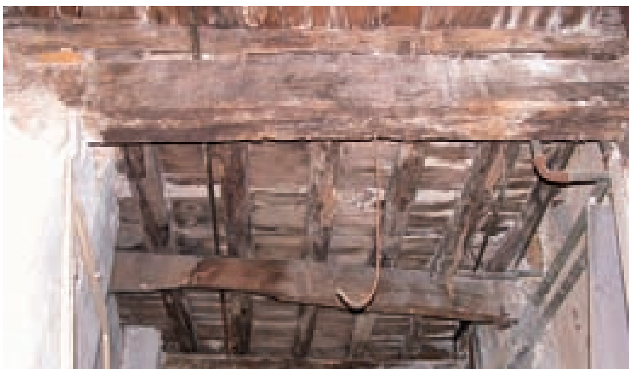
Fig. 3.150. Sanluri. Solaio intermedio ad orditura doppia. Tra il tavolato e l'orditura principale viene interposta un'orditura secondaria costituita da travicelli di dimensioni ridotte; questo caso non è frequente.
