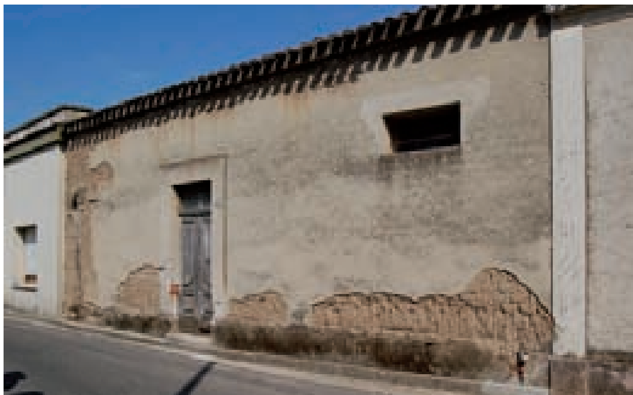
Fig. 3.144. Solarussa. Solaio latero-cementizio su muratura in mattoni crudi. La sostituzione del solaio in legno determina una nuova configurazione strutturale e formale, denunciata dallo spessore dell’oggetto, che determina un contrasto irrisolto con l’assetto storico della costruzione.
