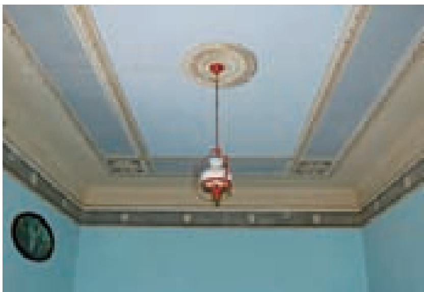
Fig. 3.153. Solarussa. Controsoffitto in canne intonato e decorato con modanature e disegni.
