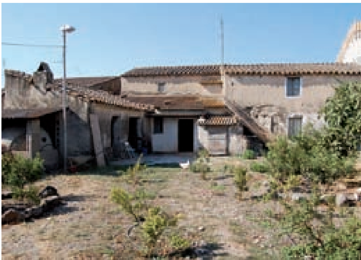
Figg. 2.39, 2.40. Uras (Campidano centrale). Casa a corte doppia di medio proprietario su lotto passante. Viste della corte di accesso e della corte rustica.
