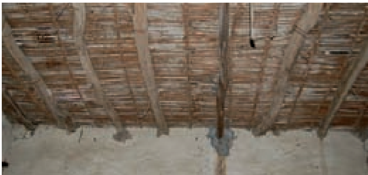
Fig. 4.47. Le travi di copertura e i loro appoggi. Silqua, nel Cixerri.
