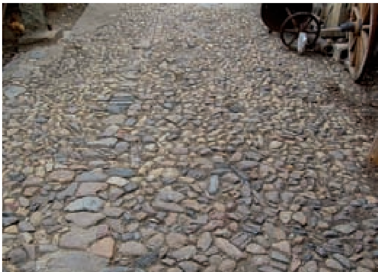
Fig. 3.154. San Gavino. Pavimentazione della corte. Il compluvio, solitamente disposto in posizione baricentrica, raccoglie l'acqua dell'intero spazio aperto della corte convogliandola alla strada attraverso il portale di ingresso.
