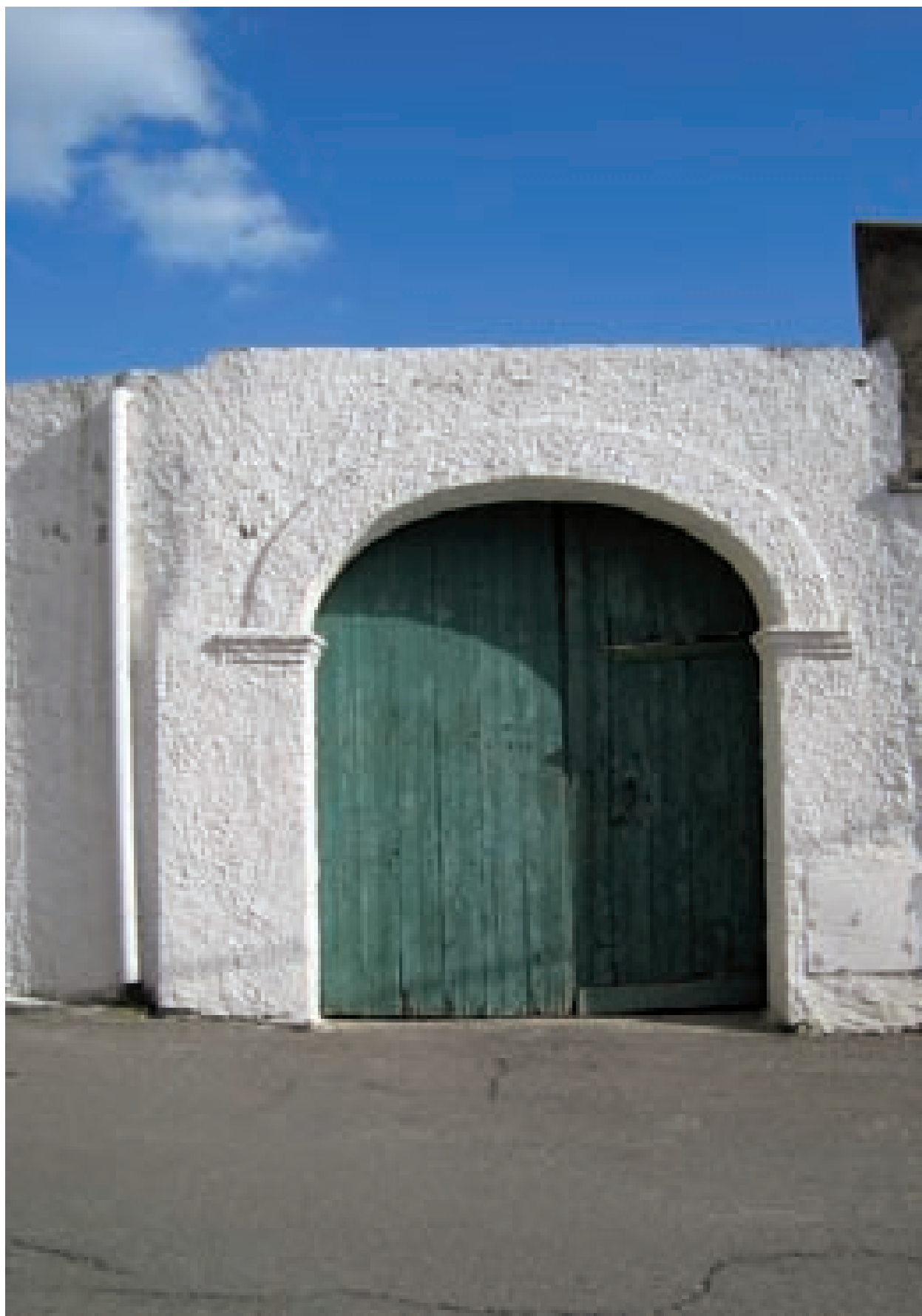
Fig. 3.52. Villaputzu. Portale con arco a tre centri e infisso in tavole di legno accostate, montate su telaio interno. Una delle ante del portale è munita di porta indipendente per il passaggio pedonale.
