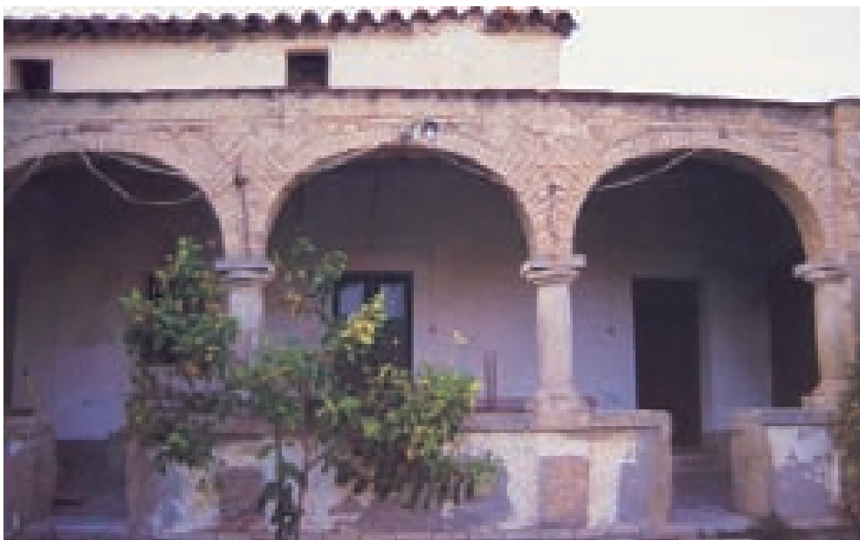
Fig. 2.31. Quartu. Case a corte di medio proprietario con loggiato. L'uso dell'arco a tre centri in cotto è un dato ricorrente nei loggiati delle case del sud così come l'impiego di monoliti in pietra locale per la realizzazione dei piedritti.
