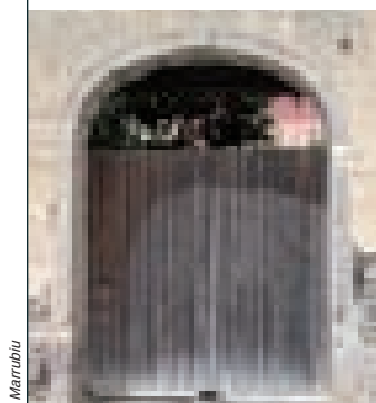
B_b 8 Arco a sesto ribassato con apparecchiatura a due teste in mattoni crudi su stipiti in mattoni crudi
