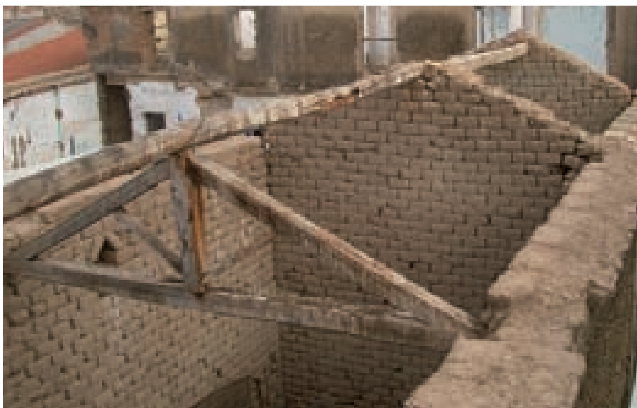
Fig. 4.3. Vallermosa, nel Cixerri. Fase di recupero di una casa storico-tradizionale. La messa a nudo della scatola muraria evidenzia le relazioni tra le cellule e la coerenza dell'intera fabbrica, dove ogni setto murario gioca un ruolo fondamentale, complementare agli altri, nell'equilibrio dell'organismo edilizio. Qualunque intervento di recupero non può prescindere da una conoscenza approfondita del rapporto tra gli elementi di fabbrica la cui alterazione potrebbe compromettere la sopravvivenza dell'intero edificio.
