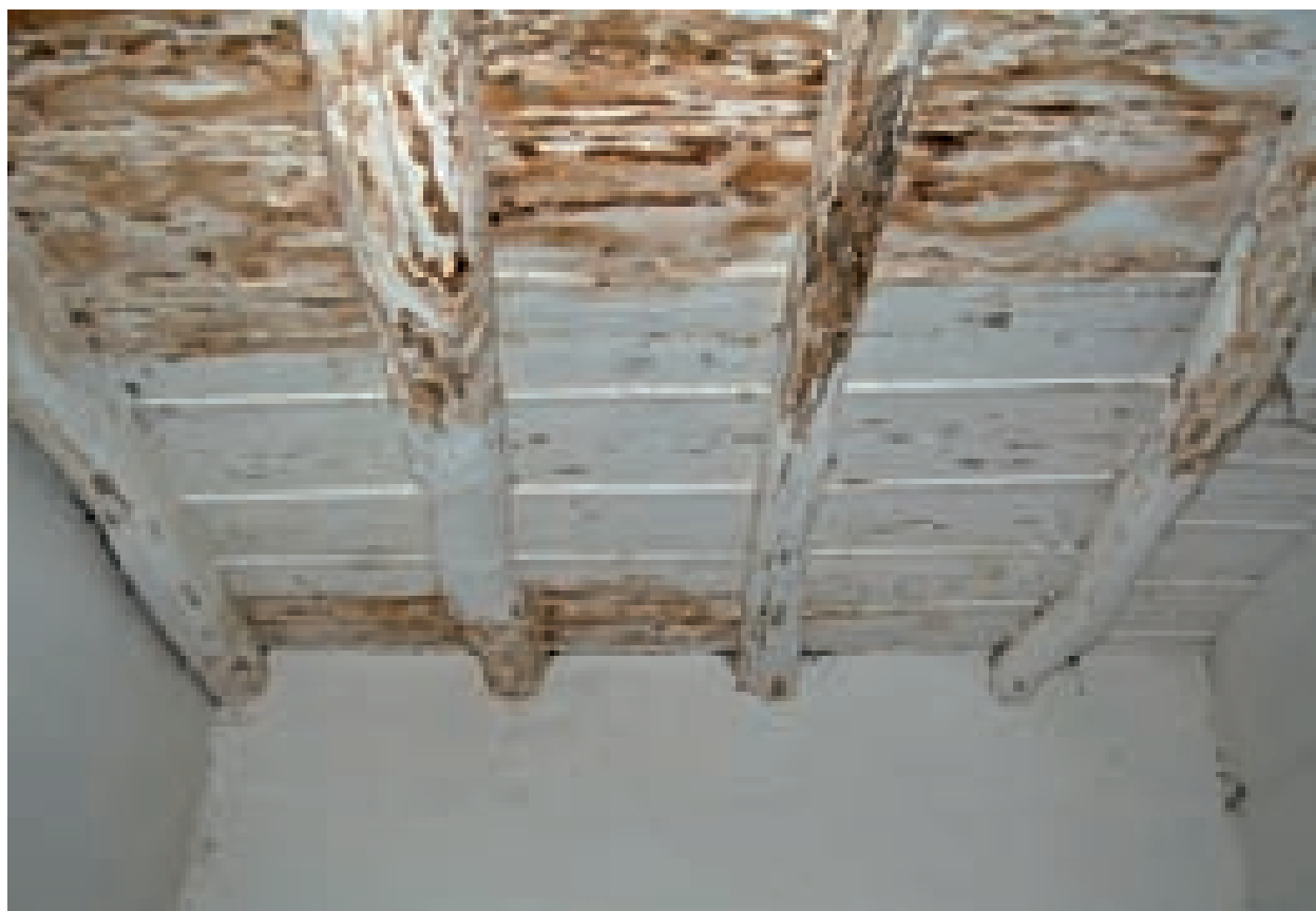
Fig. 3.147. Siliqua. solaio intermedio ad orditura semplice, realizzato con travi ottenute direttamente da tronchi semplicemente scortecciati e tavolato soprastante.
