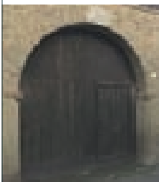
A_a 8 Arco in mattoni cotti con apparecchiatura a due teste su stipiti in elementi monolitici
