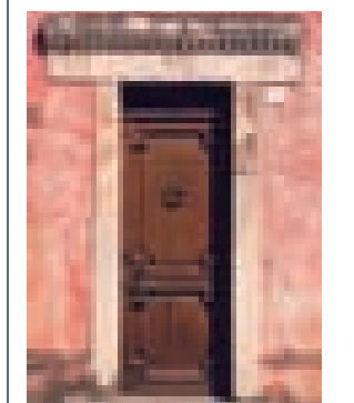
A_b 2 Porta con architrave lapideo monolitico con decori ad intaglio e stipiti lapidei monolitici
