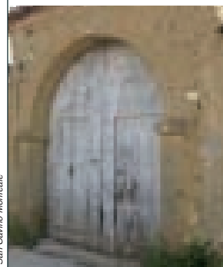
A_a 6 Arco in mattoni cotti con apparecchiatura a due teste su stipiti in mattoni cotti
