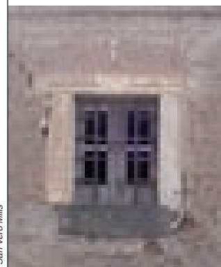
B_a 3 Finestra con architrave e stipiti lapidei con arco di scarico in mattoni crudi
