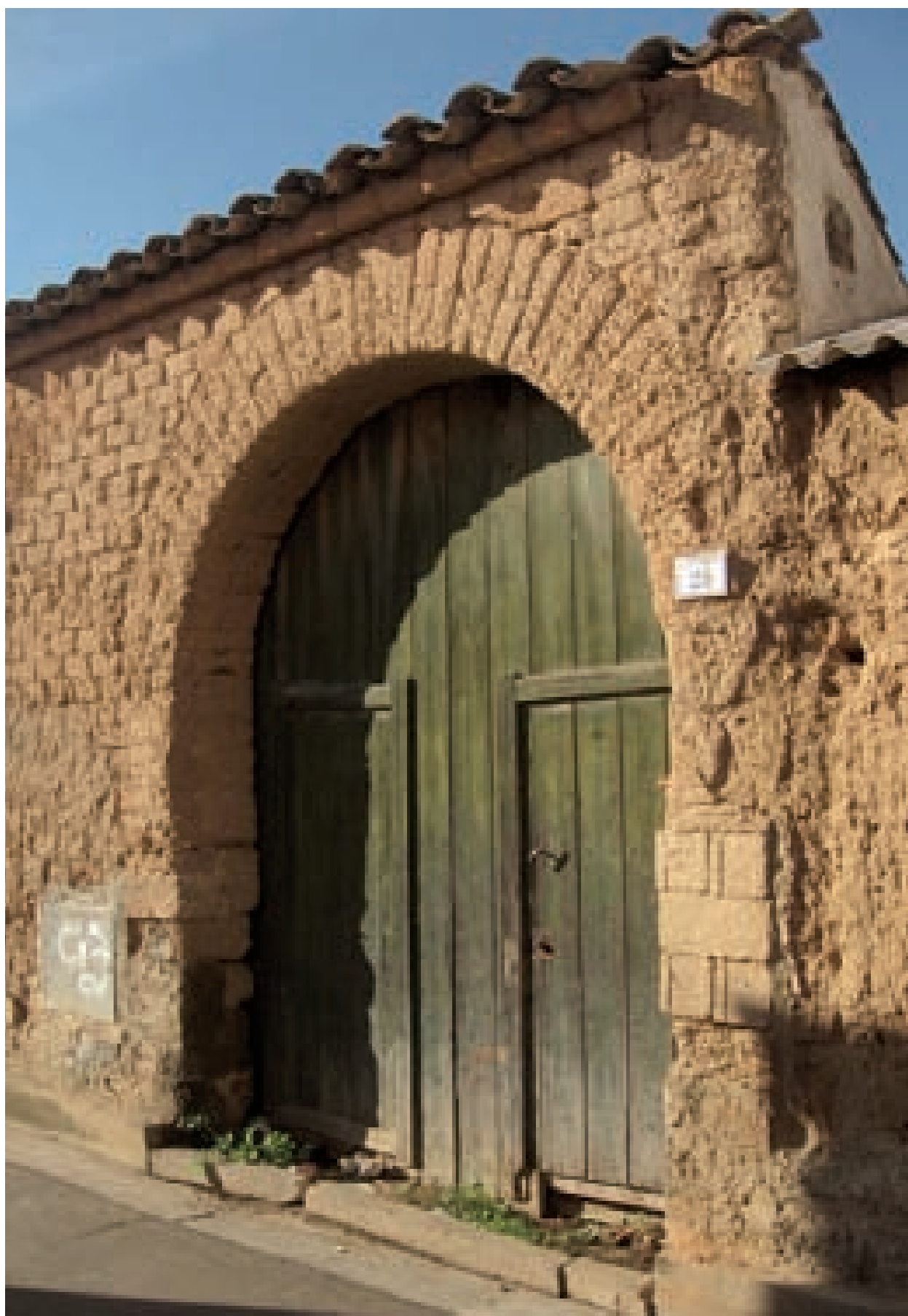
Fig. 3.59. Serramanna. Portale con arco a tutto sesto in mattoni di terra cruda.
