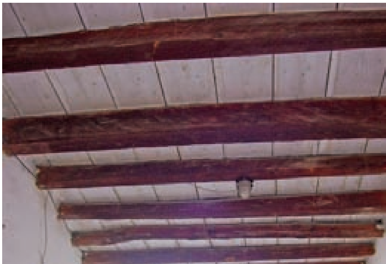
Fig. 3.147. Quartu. Solaio intermedio ad orditura semplice. Il tavolato viene semplicemente sovrapposto e chiodato all'orditura principale, costituita da travi a sezione rettangolare, come in questo caso, o circolare. Il tavolato può essere semplicemente accostato, battentato o maschiato.
