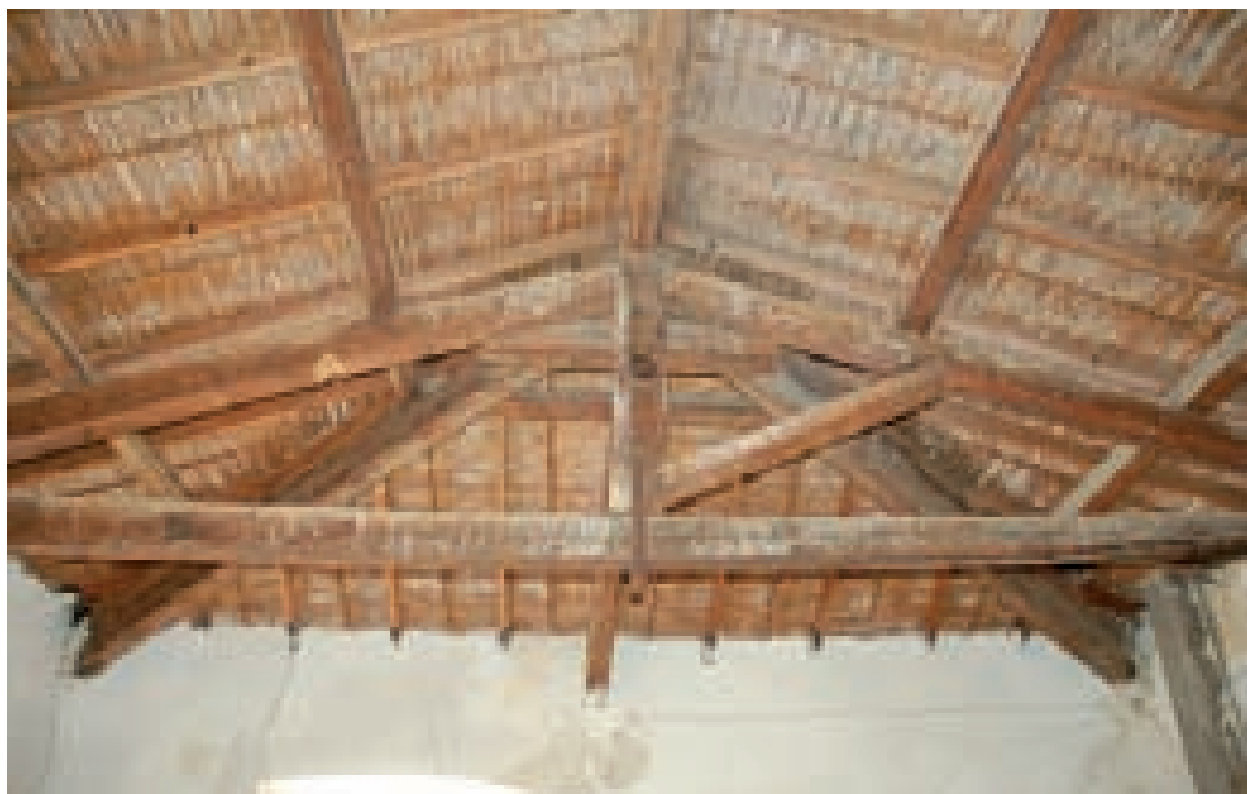
Fig. 3.126. Sanluri. Struttura portante della copertura a padiglione.
