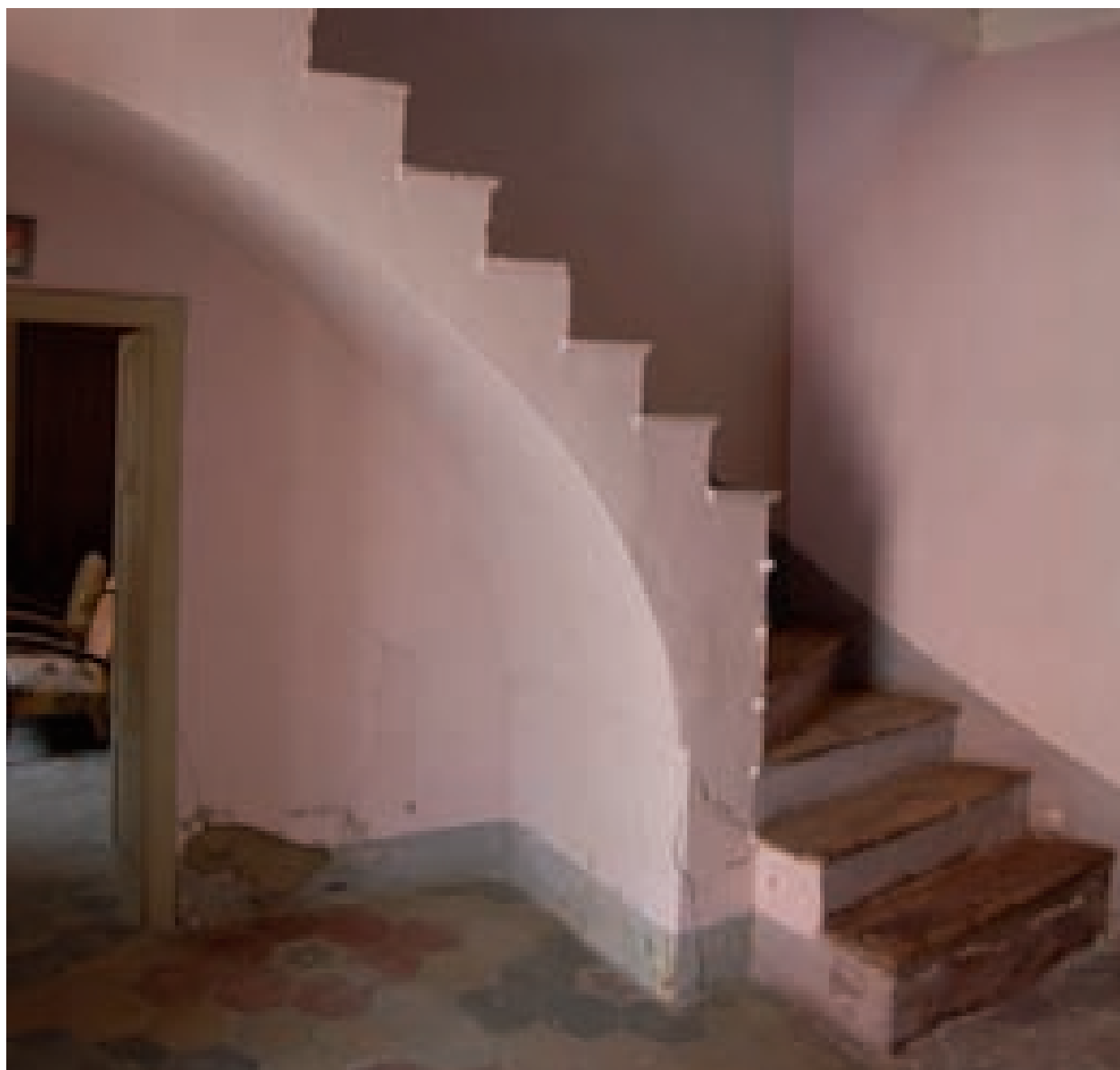
Figg. 3.177, 3.178. San Gavino. Scala con struttura ad arco rampante realizzata con un foglio di mattoni di terra cruda. Il podio dei primi tre gradini con relativo pianerottolo funge da struttura d'imposta per l'arco rampante del quale può contrastare la spinta orizzontale. In soommità l'arco rampante è direttamente impostato sul muro perimetrale.
