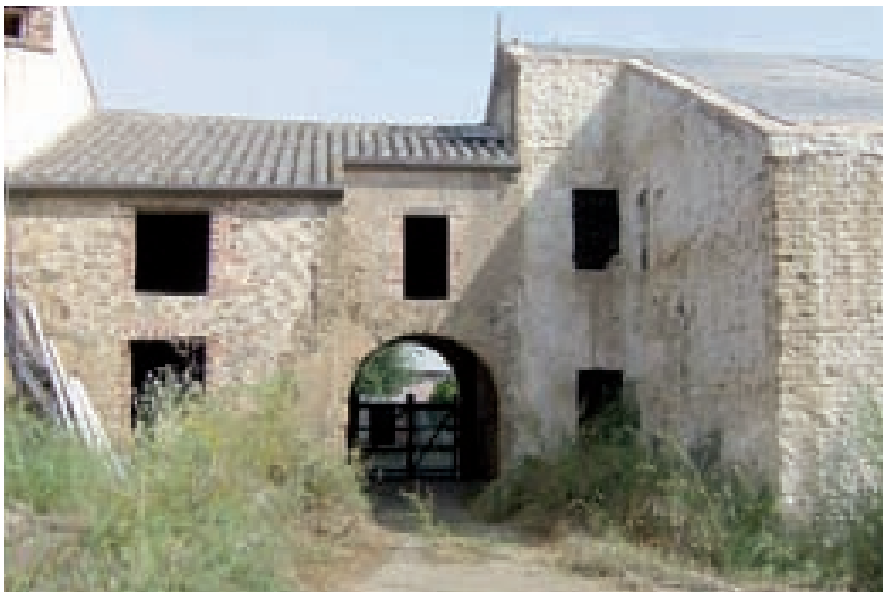
Fig. 2.67. Casa a corte di grande proprietario a Villamassargia, vista del passo carraio attraverso il corpo di fabbrica residenziale, dalla corte principale.
