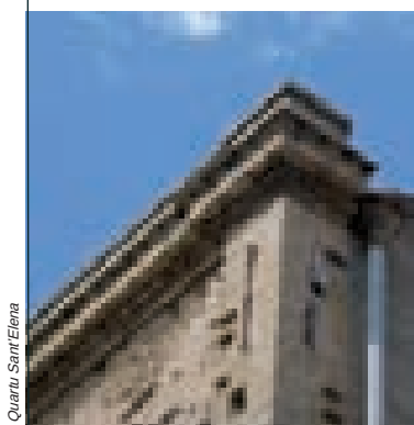
A_b 1 Canale di gronda con muretto d'attico e cornice
