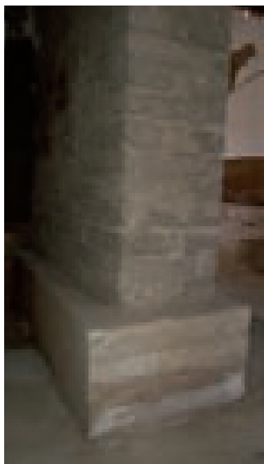
Figg. 4.10, 4.11. Le sottofondazioni. Fasi di cantiere nel recupero di una casa storico-tradizionale a Cabras, nel Campidano settentrionale.
