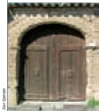
B_b 4 Arco policentrico con apparecchiatura a due teste in mattoni cotti e stipiti monolitici
