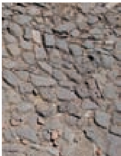
Figg. 3.155, 3.156. Serramanna, Uras, San Vito. Dettagli di pavimentazioni di corti realizzate con ciottoli e pietre locali.
