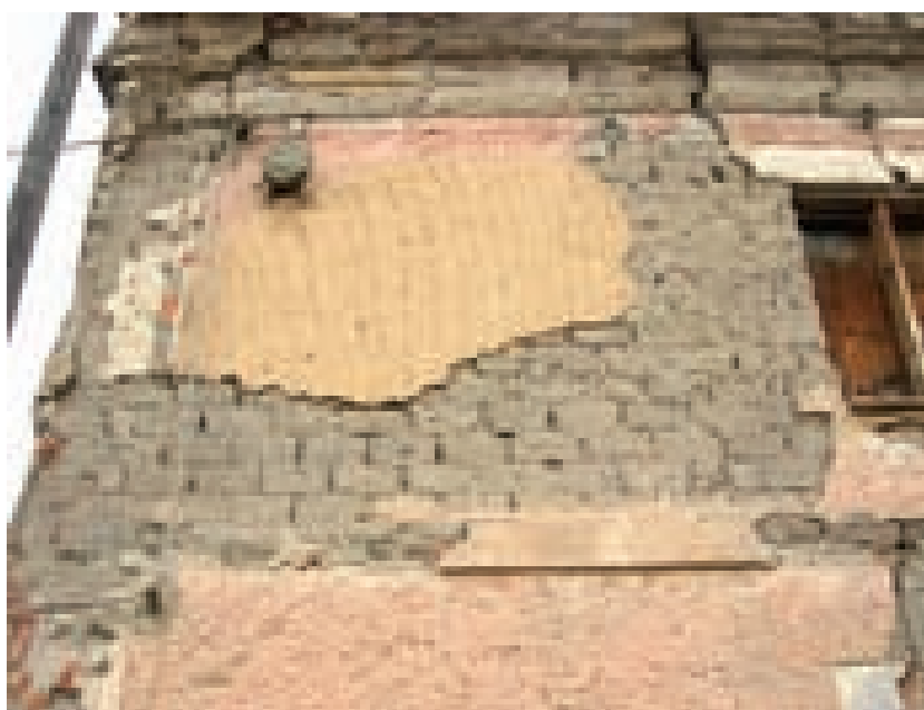
Fig. 4.27. Il degrado degli intonaci. Uras, nel Campidano settentrionale. Erosione dovuta all'azione combinata degli agenti atmosferici quali pioggia e vento.
