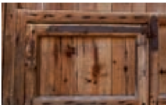
Fig. 3.69. Particolare della bandella superiore, che consente il movimento di apertura della porta per l'accesso pedonale sull'anta del portale.
