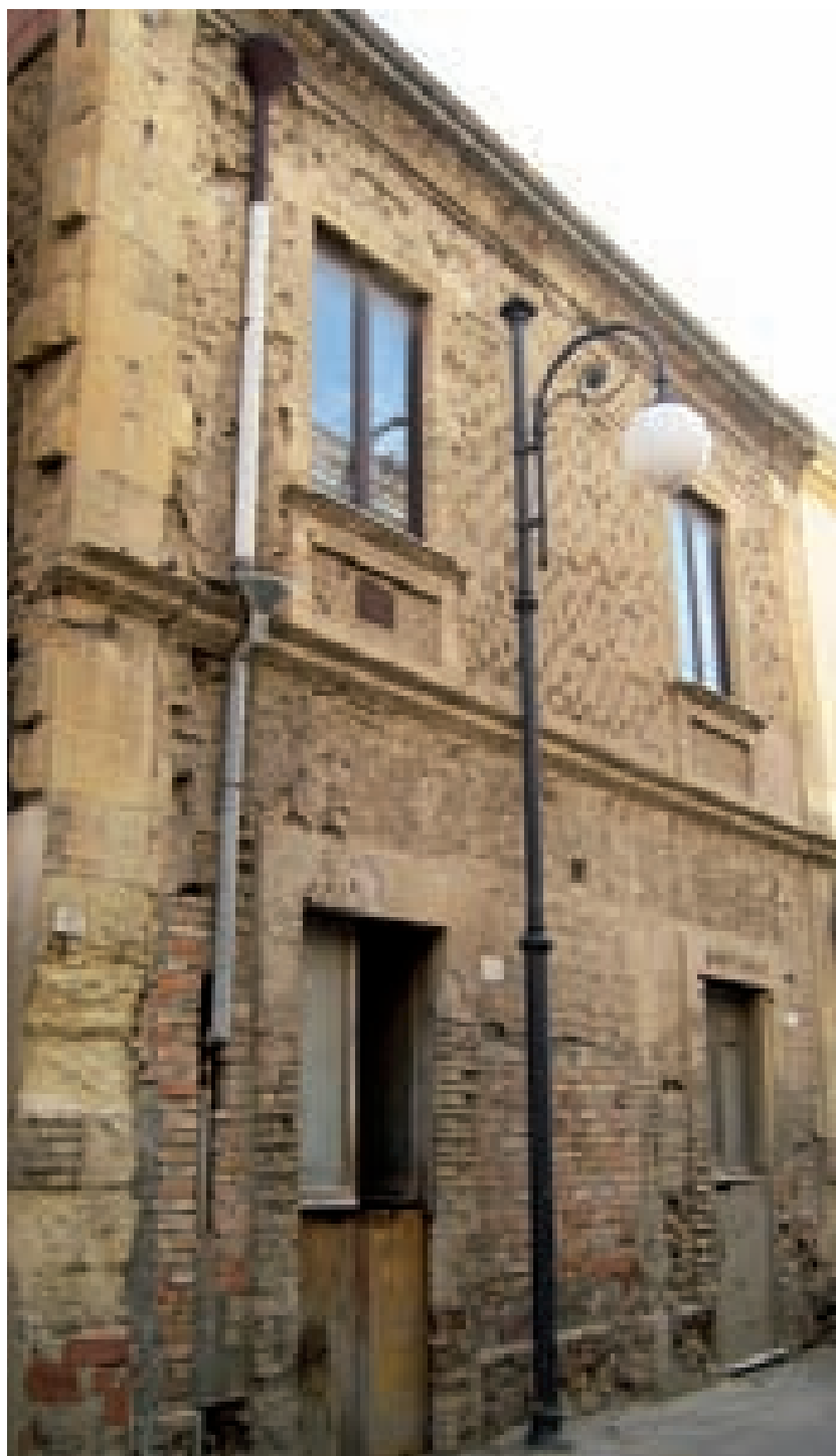
Fig. 3.18. Quartu. Esempio di integrazione terra cruda-laterizio-pietra in cui i tre materiali vengono utilizzati nei diversi elementi costruttivi in funzione delle rispettive proprietà meccaniche.
