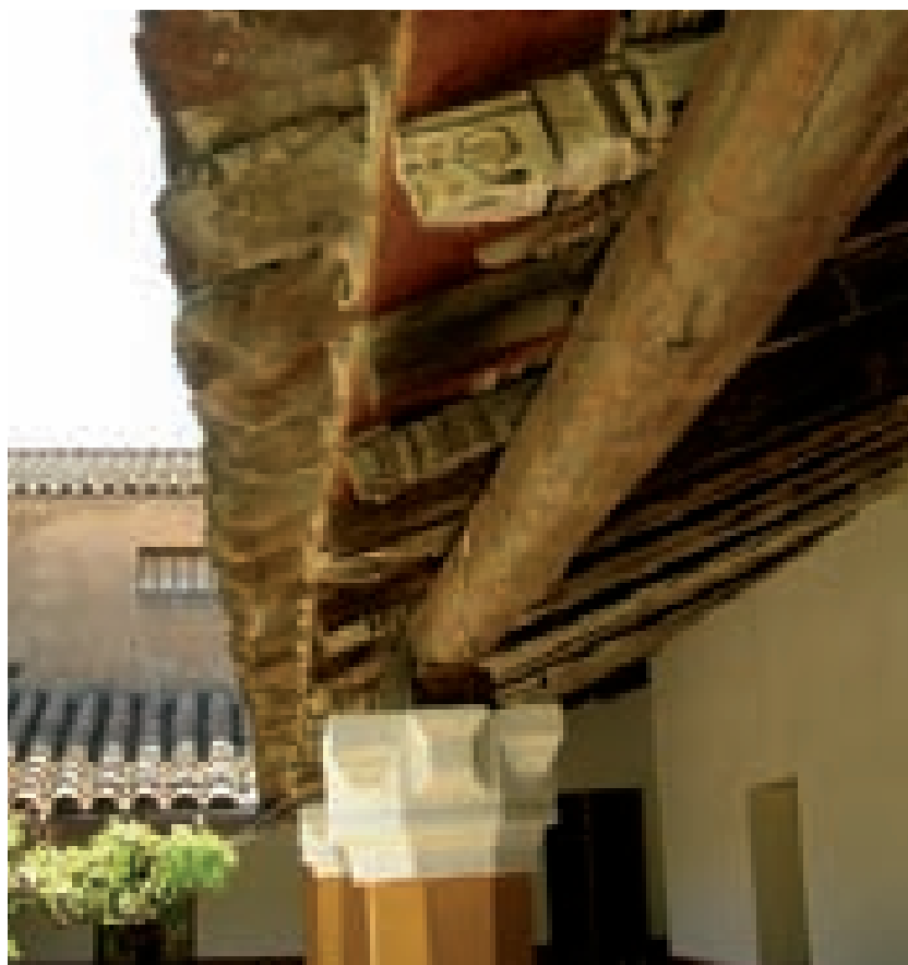
Particolari dell'aggancio dell'orditura secondaria con i pilastri.
