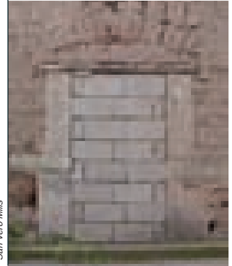
B_a 3 Porta con orizzontamento ligneo su stipiti lapidei e arco di scarico in crudo
