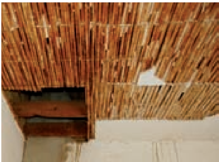
Fig. 3.152. San Gavino. Controsoffitto in canne con intonaco in malta di calce, sostenuto da apposita struttura a travicelli lignei.
