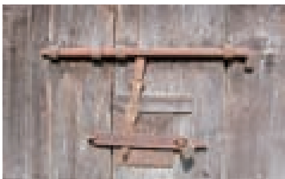
Fig. 3.71. Particolare della chiusura (esterna): asta mobile a sezione circolare.
