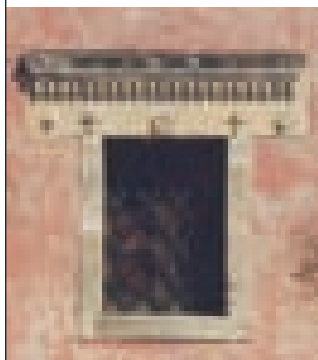
A_b 2 Finestra con architrave lapideo monolitico con decori in rilievo e stipiti lapidei monolitici
