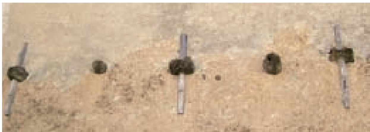
Fig. 3.146. Sinnai. Le teste delle travi maestre del solaio intermedio alternativamente assicurate al muro con capochiave di legno.
