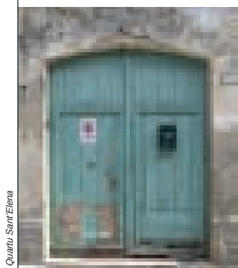
B_b 10 Arco a sesto ribassato con apparecchiatura a due teste e stipiti in mattoni cotti
