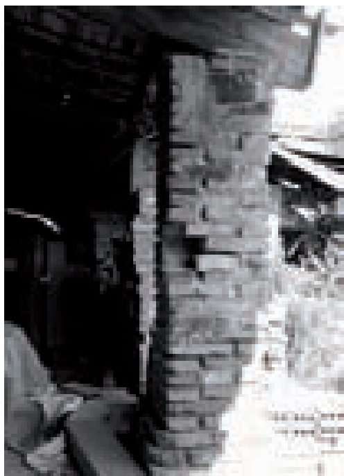
Particolare dei pilastri del rustico.
