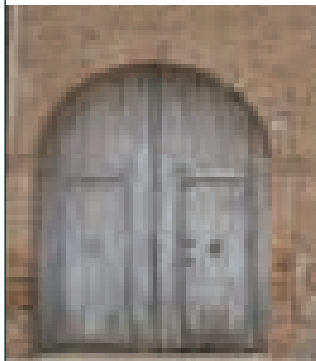
B_d 2 Arco policentrico in mattoni cotti, con apparecchiatura a due teste su stipiti di mattoni cotti
