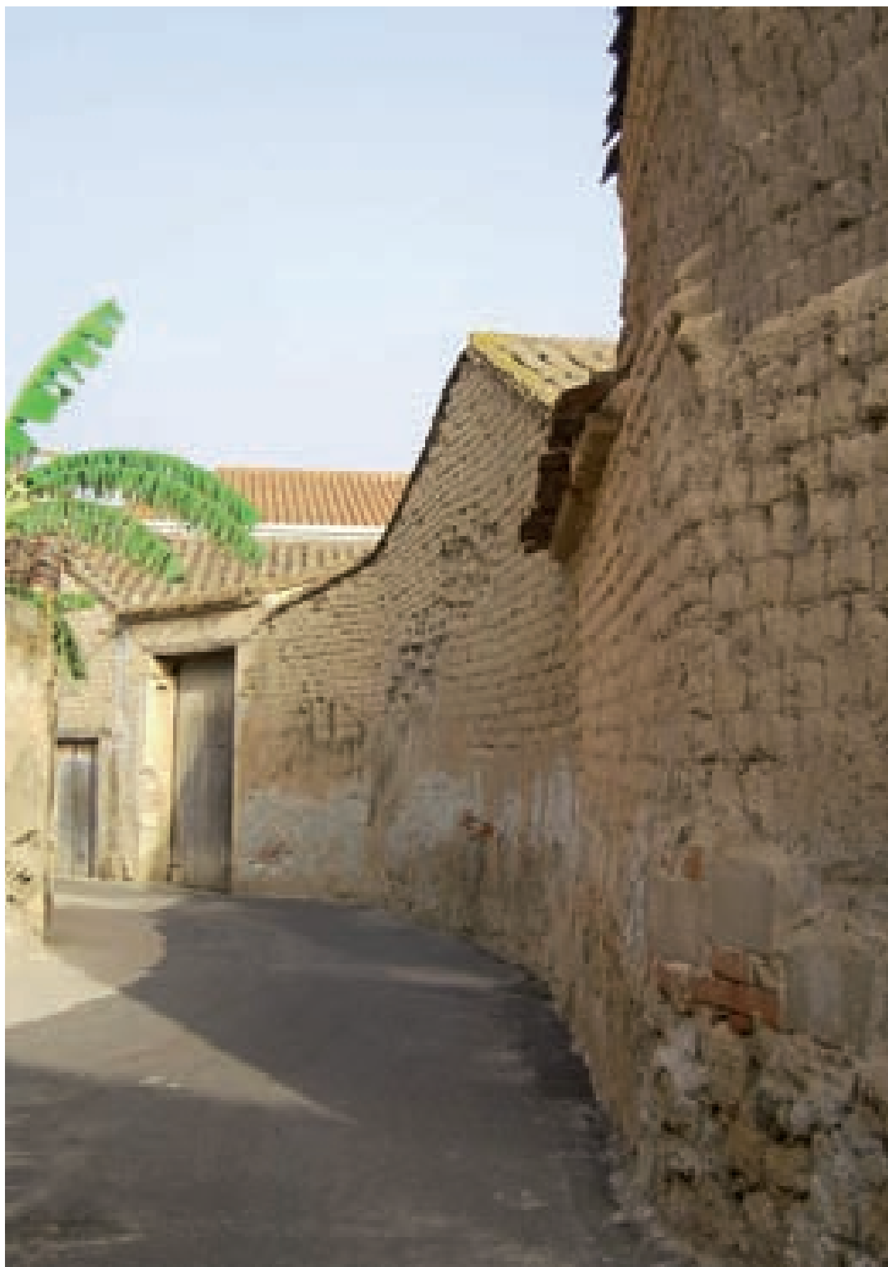
Fig. 2.53. Nurachi (Campidano settentrionale). Casa di grande proprietario a corte retrostante con sala: vista dal percorso laterale di accesso alla corte. In primo piano la testata del corpo di fabbrica residenziale, il recinto, i vani strumentali e il portale architravato.
