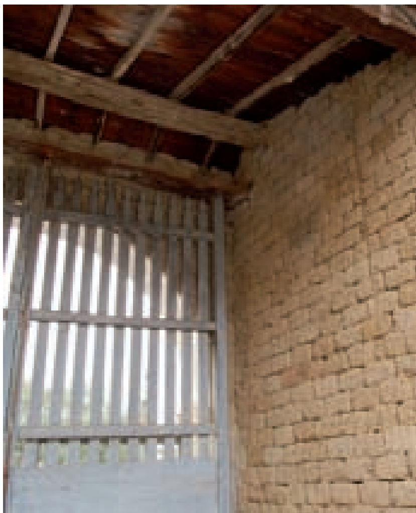
Fig. 3.51. San Gavino. Vista interna del portale. Questo tipo di portale denominato "ecca" o "gecca" è diffuso nel Campidano centrale e nel Sarrabus, è realizzato con assi di legno non accostate collegate ad un telaio rigido e permettono la permeabilità visiva attraverso l'infisso.
