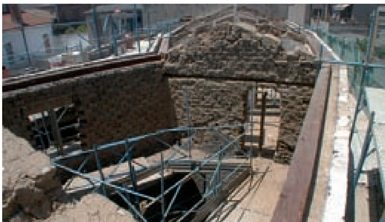
Fig. 4.23. I cordoli. Fasi di cantiere nel recupero di una casa storico-tradizionale a Villamassargia, nel Cixerri. Posizionamento dei dormienti lignei.
