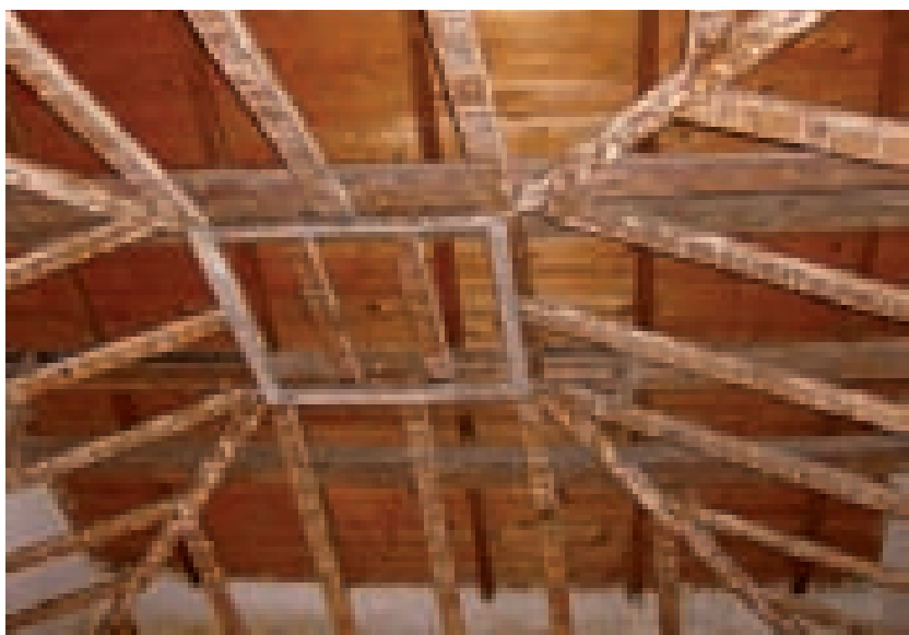
Fig. 3.150. Solarussa. Struttura lignea di sostegno per una volta da realizzarsi con incanniccato intonato all'intradosso, secondo una prassi abbastanza comune nelle abitazioni della borghesia agraria.
