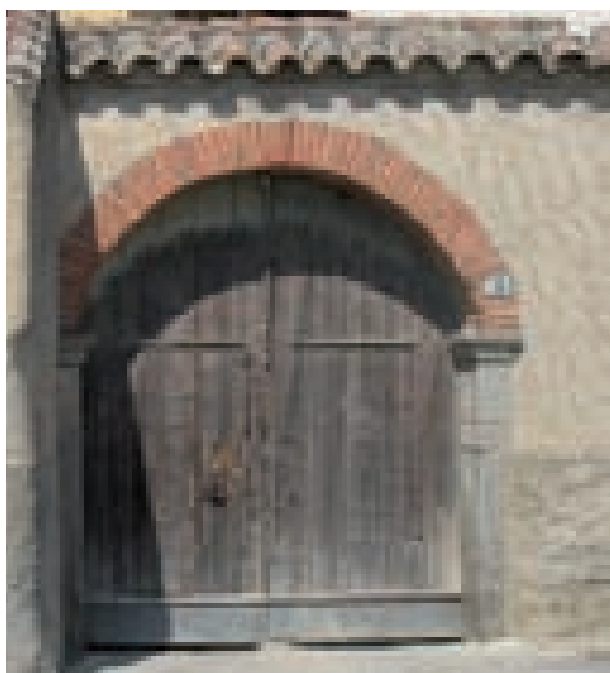
Figg. 3.67 e 3.68. Uras. Vista dall'esterno e dall'interno di un portale. L'infisso realizzato con uno schema ricorrente in tutto l'ambito territoriale della terra cruda, è costituito da tavole collegate ad un telaio in montanti e traversi lignei. È presente la porta per l'accesso pedonale su una delle ante, riprodotta all'esterno in falso sull'altra.
