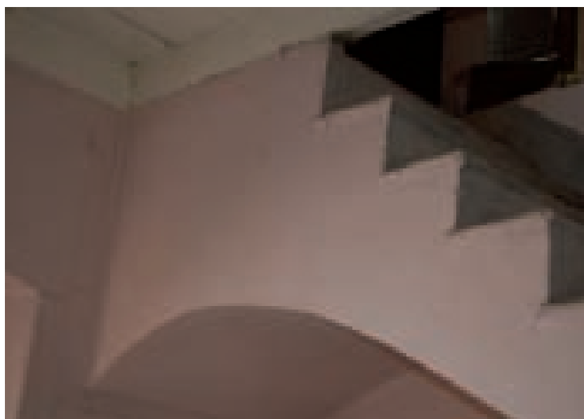
Figg. 3.177, 3.178. San Gavino. Scala con struttura ad arco rampante realizzata con un foglio di mattoni di terra cruda. Il podio dei primi tre gradini con relativo pianerottolo funge da struttura d'imposta per l'arco rampante del quale può contrastare la spinta orizzontale. In soommità l'arco rampante è direttamente impostato sul muro perimetrale.
