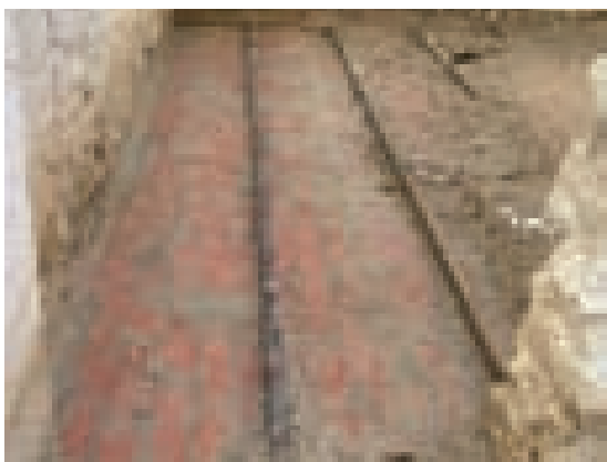
Fig. 3.41. Vista dall'estradosso del solaio intermedio in voltine in laterizi cotti e putrelle in ferro.
