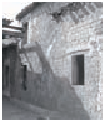
Viste del corpo abitativo dalla strada e dalla corte.
