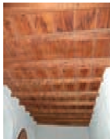
Fig. 3.4. Vista del solaio intermedio del loggiato del corpo principale.
