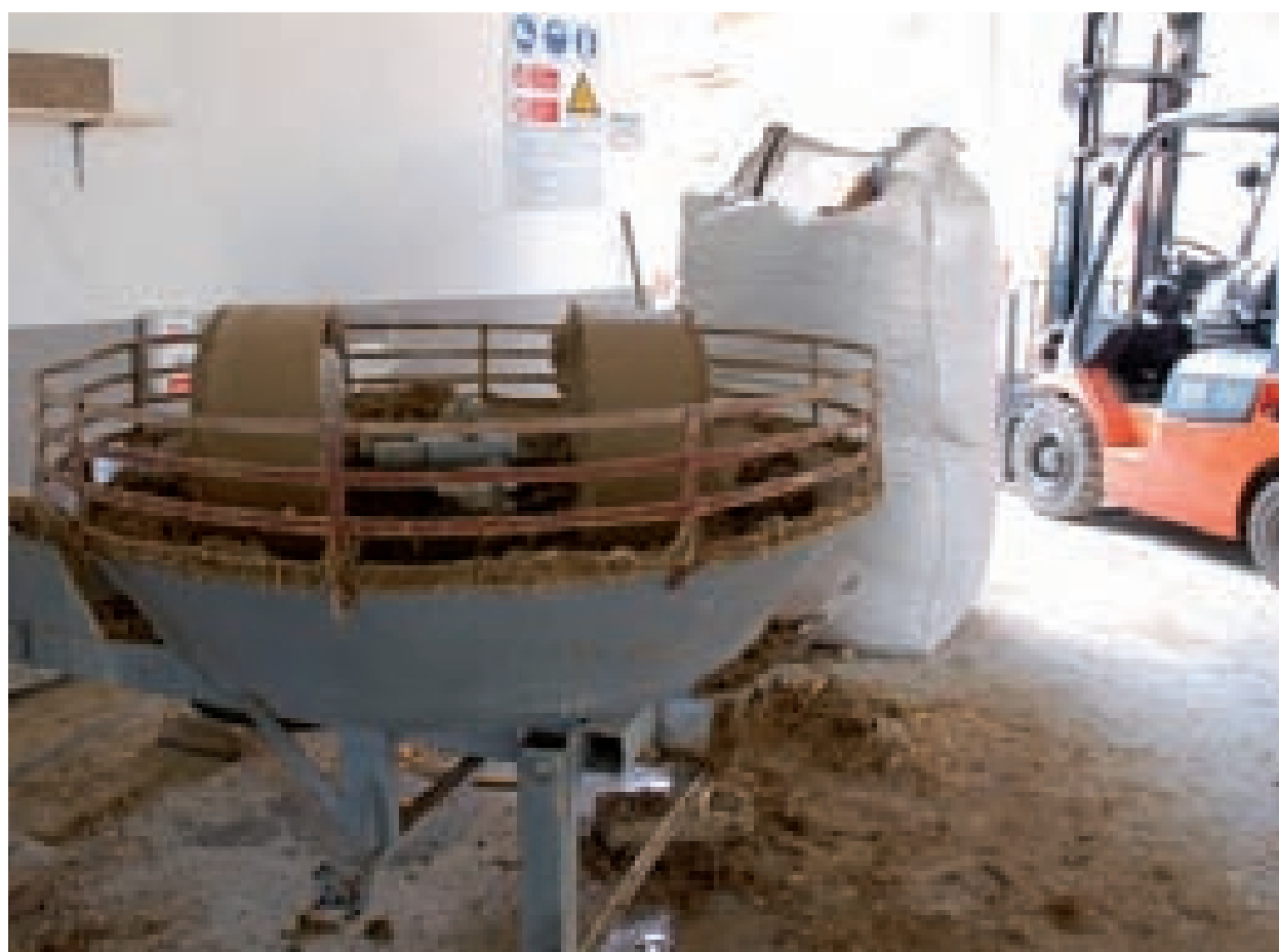
Fig 2.1. Cantiere Mauro Coni, Ales. Preparazione dell'impasto.
