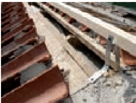
Fig. 3.29. Fasi di ricostruzione del sistema di copertura ventilato. Dettaglio del listello ligneo porta-colmo sorretto da profilati metallici.
