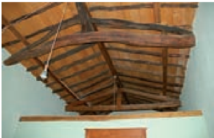
Fig. 3.6. Vista del corpo principale, il rifacimento della copertura con tavolato ligneo e tetto ventilato.
