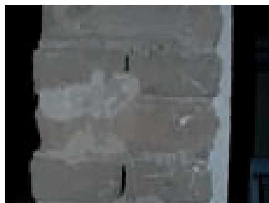
Fig. 3.56. Dettaglio di un'apertura interna in corrispondenza dello stipite in mattoni di terra cruda. Finitura realizzata con intonaco di terra e calce.
