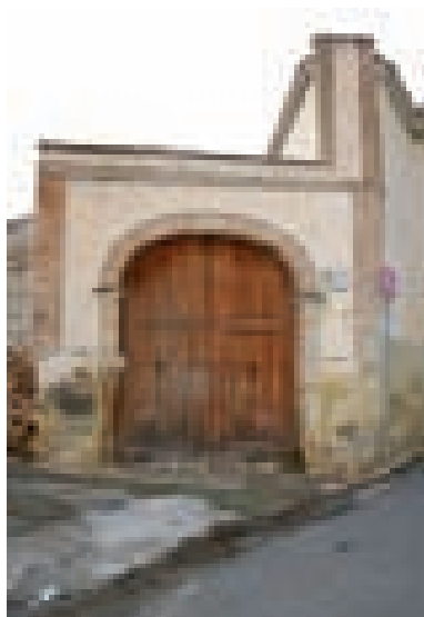
Figg. 3.1, 3.2. Vista del portale d'accesso e del loggiato del corpo principale.
