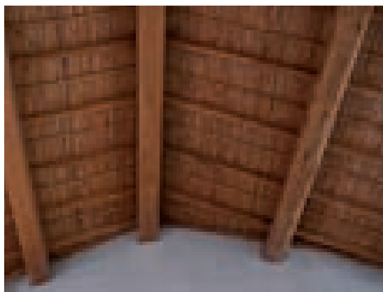
Fig. 3.58. Dettaglio dell'intradosso della copertura ricostruito secondo tecniche tradizionali. Struttura lignea e incanniciato.
