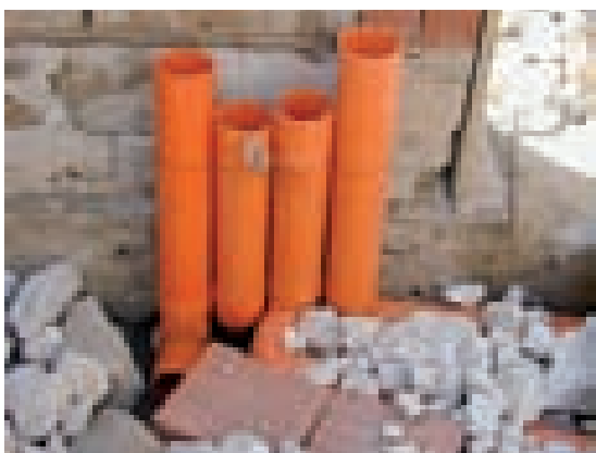
Fig. 3.21. Sistema di aerazione del vespaio: raccordo tra le canalizzazioni orizzontali e verticali viste dall'interno dell'edificio durante la realizzazione.
