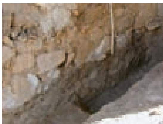
Fig. 3.22. Fasi di risanamento delle fondazioni, scavo di ispezione sino alla quota di posa del basamento.
