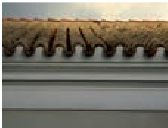
Fig. 3.60. Dettaglio del sistema di gronda con tegole aggettanti su cornicione modanato ricostruito secondo il disegno originario.
