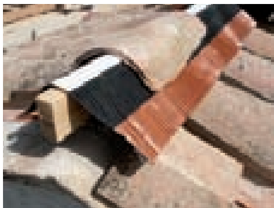
Fig. 3.30. Fasi di ricostruzione del sistema di copertura ventilato. Dettaglio del foglio di rivestimento isolante di polipropilene e rame, permeabile all'aria ed idrorepellente.
