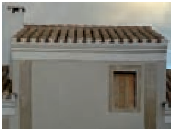
Fig. 3.62. Dettaglio di facciata. Rifacimento intonaci in terra e calce con restauro del decoro di facciata costituito da paraste in lieve rilievo.
