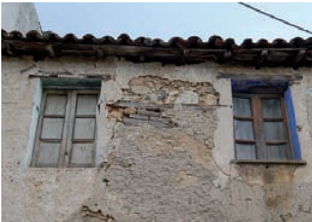
Fig. 3.95. Fonni; finestre a due ante tripartite per mezzo di traversi in pino di circa 5x2 cm, con interasse di circa 25 cm.
