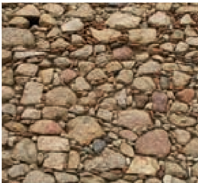
Figg. 3.22, 3.23. Sezione e prospetto di apparecchi murari in trovanti lapidei di varia natura e pezzatura, realizzati senza particolare cura nell'ammorsamento fra i paramenti, e stabilizzati grazie all'abbondante impiego di malta di terra (come visibile nella sezione muraria rilevata ad Ilbono) o mediante rinzeppature in scaglie laterizie e lapidee (a Loculi).
