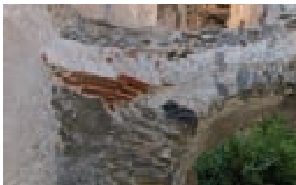
Figg. 3.161, 3.162. Dettagli dei pennacchi di una volta a vela, nei quali si può notare la differente composizione del rinfiacco. Nel primo esempio il rinfiacco è realizzato con pietrame di piccola e media pezzatura e terra sciolta; nel secondo caso il rinfiacco è realizzato quasi totalmente in terra fino allo strato di allettamento.
