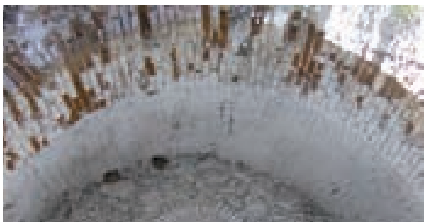
Fig. 3.147. Orosei; volta a botte in laterizi; all'intradosso sono ben visibili i segni dell'incanniccio delle centine.
