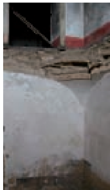
Figg. 4.58, 4.59. Gairo. Crollo di una volta a vela in seguito ai danni causati dall'alluvione del 1951. Gavoi. Dissesti originati dal movimento relativo delle imposte della volta: crollo della volta.
