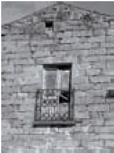
Vista del fronte laterale
