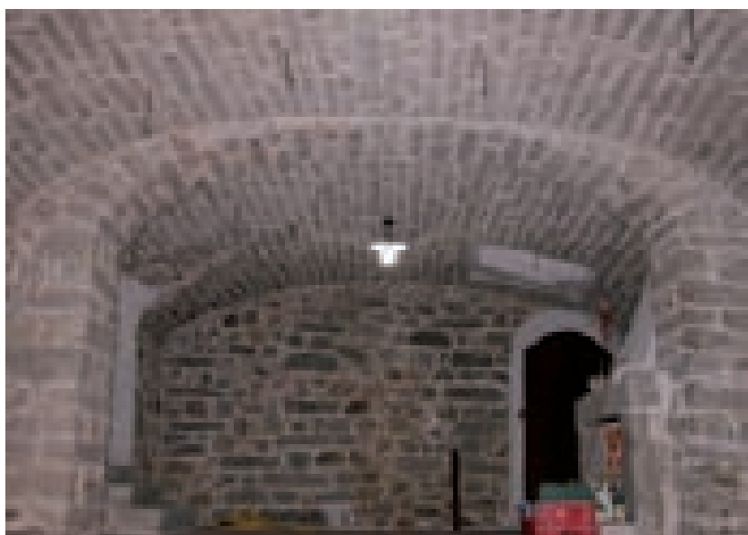
Fig. 3.143. Mamoiada; volta a botte a tre centri nel piano seminterrato dell'abitazione. La volta è interamente realizzata in conci lapidei squadrati, disposti parallelamente alla generatrice. La bucatura della volta per l'inserimento di una botola viene trattata come quella di una finestra in una muratura verticale, realizzando lateralmente degli stipiti e superiormente un'architrave monolitico.
