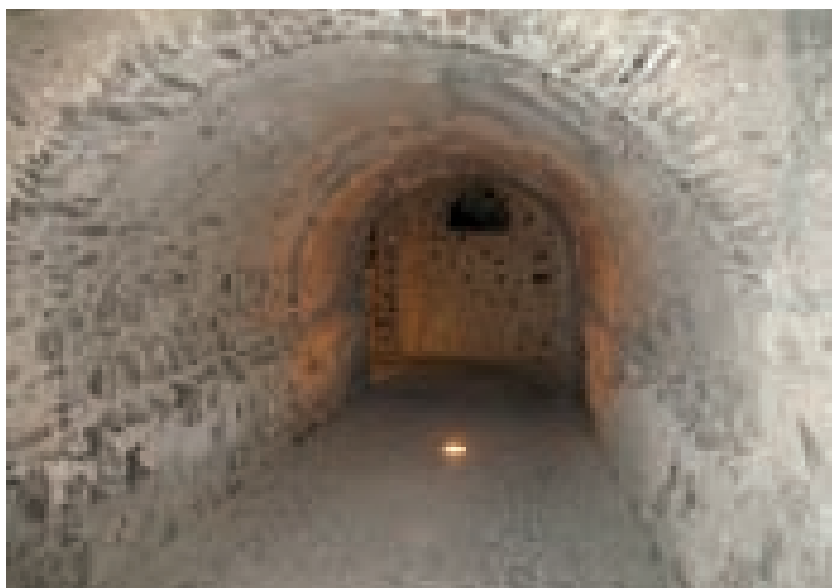
Fig. 3.141. Orosei; passaggio carrabile di accesso alla corte coperto da volta a botte in pietra. Si possono notare gli arconi di sostegno della soprastante muratura e la risega all'imposta della volta utilizzata probabilmente per l'appoggio delle basi della centina.
