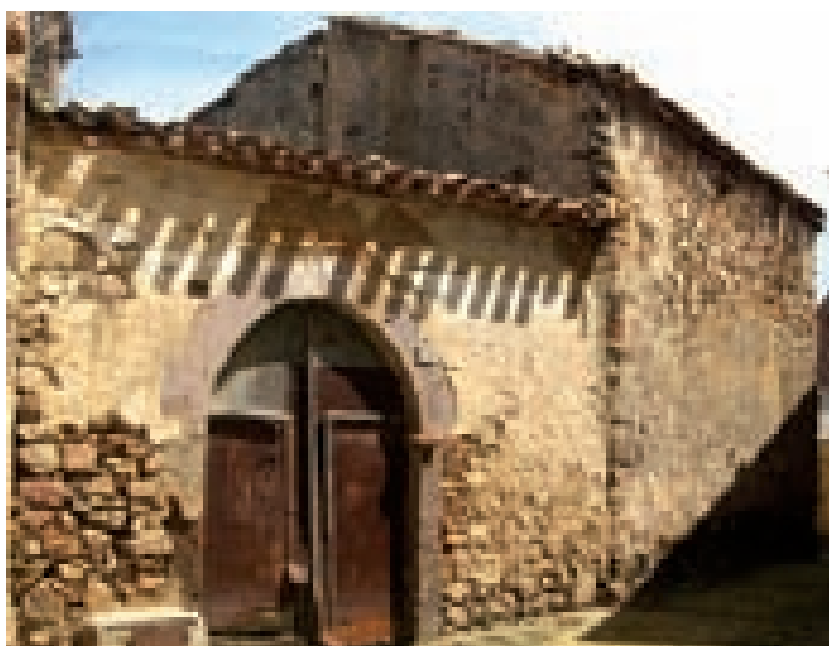
Fig. 3.74. Ortueri; Portale contornato in conci e stipiti di pietra squadrata con portone in legno rivestito di lamiera verso l'esterno.
