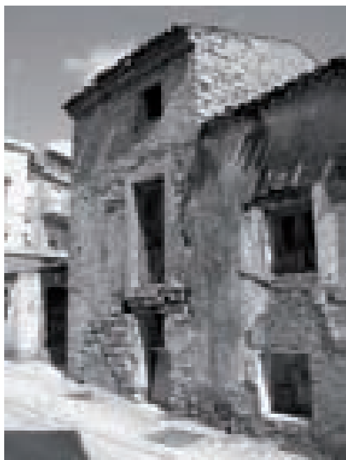
Vista del prospetto nella quale si evidenzia la rimozione della scala originaria in legno.
