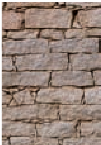
Fig. 3.13. Muratura in granito (Olzai).
