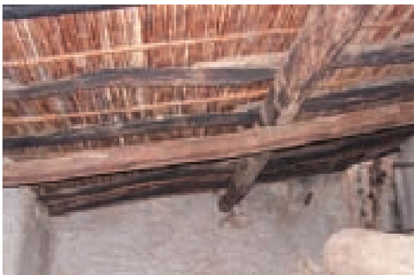
Fig. 3.100. Barisardo; solaio di copertura monofalda a tre orditure sovrapposte e impalcato in canne con canna maestra.
