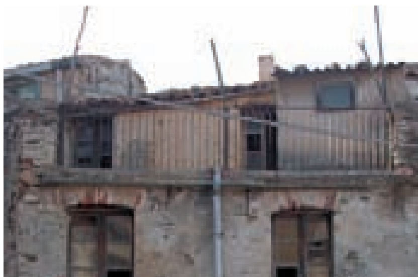
Fig. 3.109. Ussassai; copertura a terrazza di una casa sviluppata in altezza.
