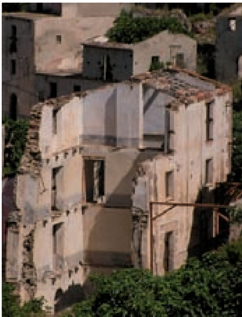
Figg. 3.9, 3.10. Gairo vecchia; esempi di edilizia lapidea a cellule murarie sovrapposte e adiacenti. Nella prima immagine è ben evidente il ruolo portante di una coppia di setti paralleli e quello controventante delle pareti ad essi ortogonali che danno stabilità alla scatola muraria in presenza di eventuali azioni orizzontali. Nella seconda, il crollo degli orizzontamenti mette in evidenza un'edilizia fatta di cellule elementari, alcune delle quali di sostruzione con sistemi voltati di sostegno delle spinte del terreno.
