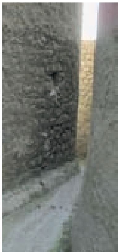
Fig. 2.44. Sarule. Sistema di raccolta delle acque meteoriche tra due abitazioni.
