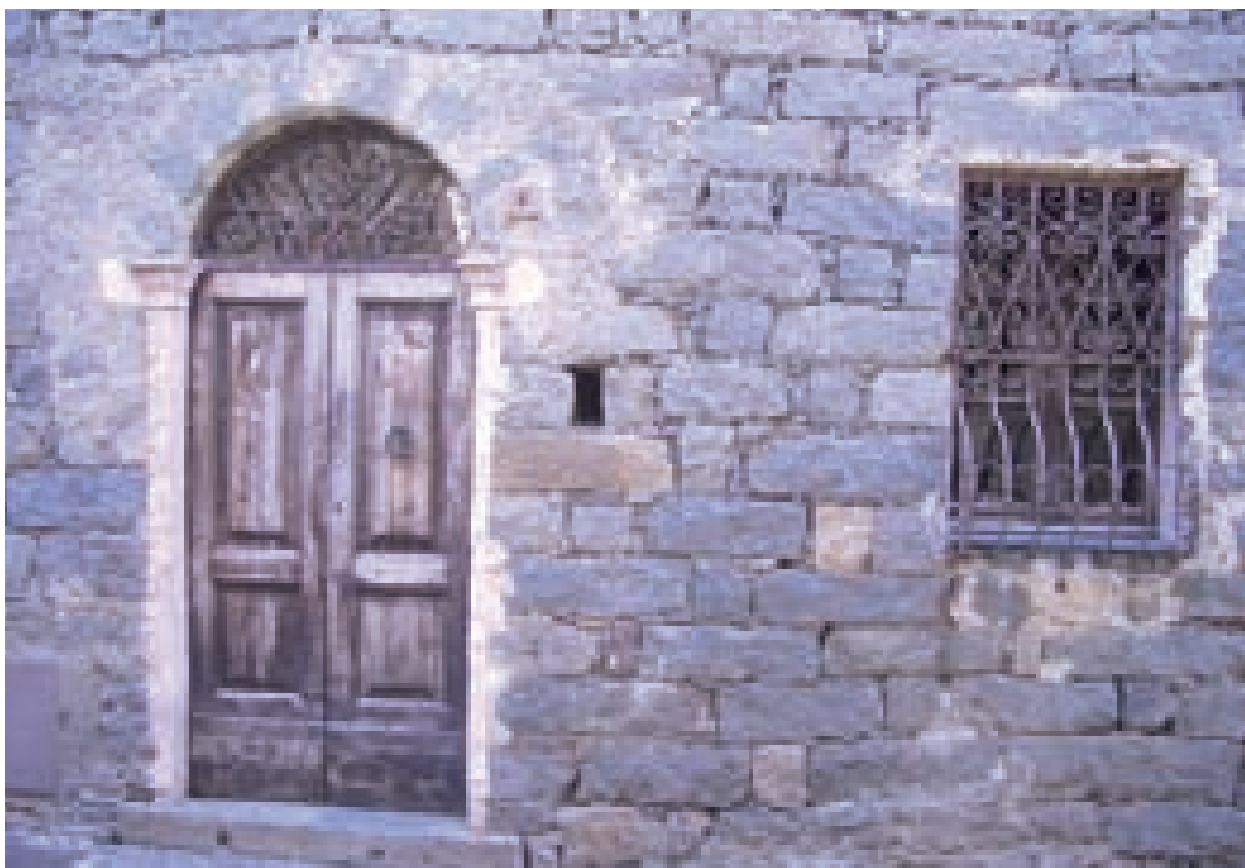
Fig. 3.96. Osidda; portoncino d'accesso con sopraluce superiore protetto da rosta metallica affiancato da una finestra a due ante tripartite protetta da inferriata.
