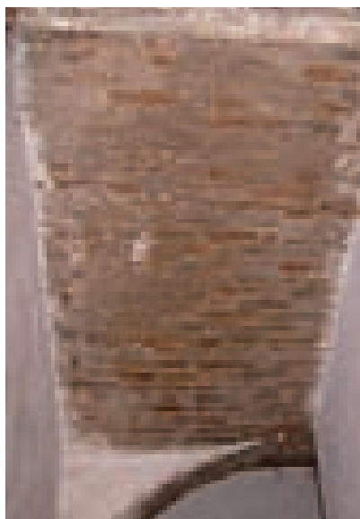
Figg. 3.205, 3.206. Intradosso della volta di mattoni laterizi che sorregge la scala: i mattoni vengono disposti di coltello parallelamente all'imposta (Oniferi).
