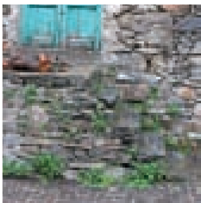
Figg. 3.229, 3.230, 3.231. Esempi di scale con piccola rampa in struttura muraria di riempimento realizzata in scisto, granito e calcare-scisto (Senlo, Urzulei, Gadoni).
