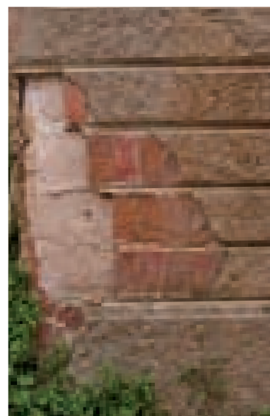
Fig. 3.52. Lanzo; rivestimento bugnato su abbassatura di laterizi in foglia.
