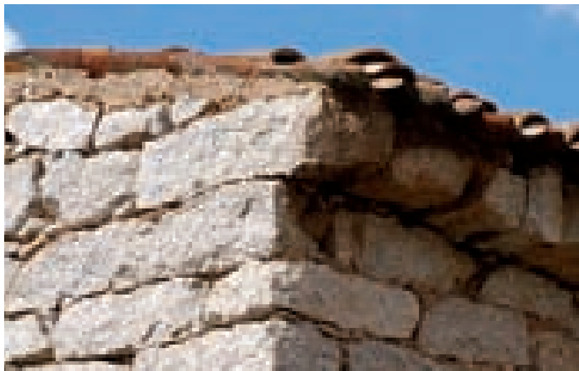
Dettaglio delle soluzioni d'angolo attacco tetto-muratura:
