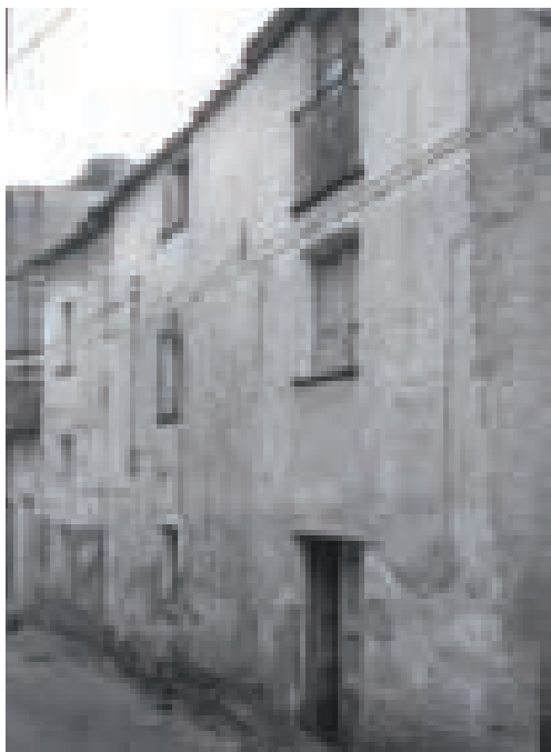
Prospetto sulla strada
