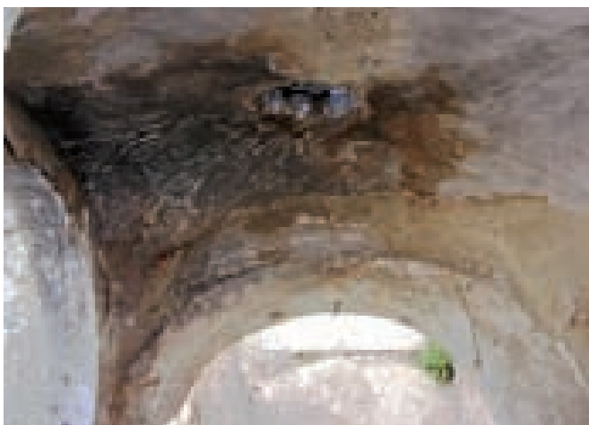
Fig. 3.154. Gairo; volta a crociera impostata su 4 archi a tutto sesto.
