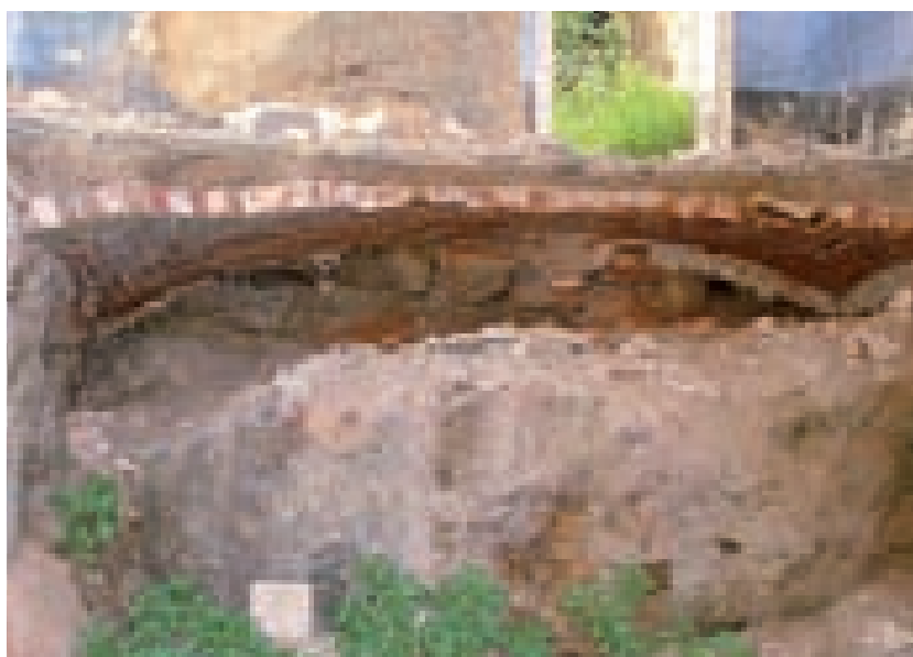
Fig. 3.151. Arzana; sezione di una volta a vela a sesto molto ribassato parzialmente crollata. L'apparecchiatura in mattoni di coltello ha giaciture parallele alle direzioni delle generatrici. Il crollo permette di scorgere il rinfiacco in terra solitamente celato alla vista dal soprastante massetto in calce o terra.
