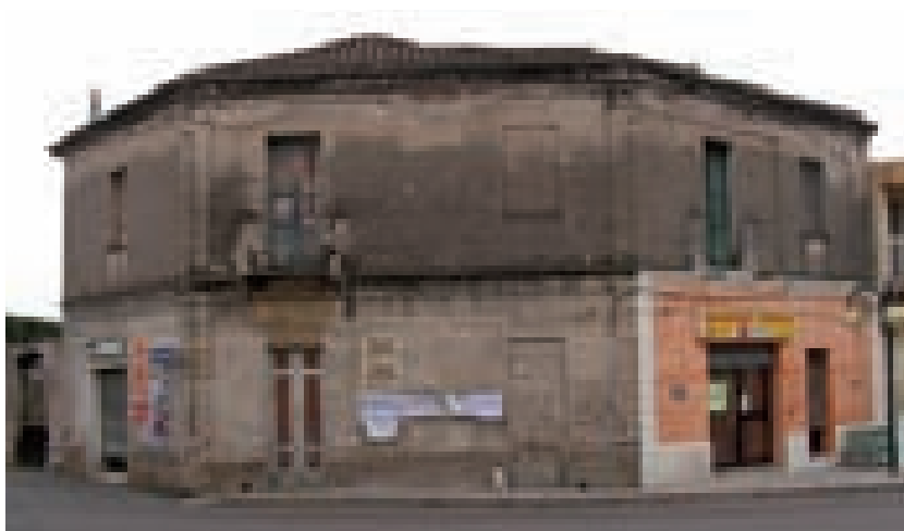
Fig. 2.64. Lotzorai. Palazzetto con corte retrostante in testata di isolato situato nei pressi dell'intersezione di più strade principali dell'abitato. La trasformazione da casa a corte a palazzetto ha comportato l'apertura di bucatore verso la strada; da notare le false finestre in omaggio alla simmetria del prospetto.
