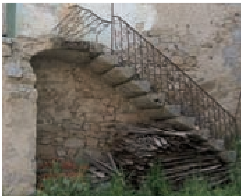
Fig. 3.225. Ollolai, scala con struttura lapidea a sbalzo. I gradini costituiti da monoliti di granito si sorreggono sia per mezzo dell'incastro nella muratura, sia per parziale appoggio sul gradino sottostante.
