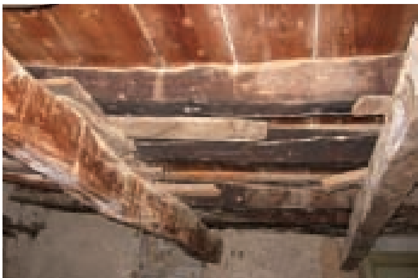
Figg. 3.131, 3.132. Solaio ad orditura doppia con impalcato in tavole in due esempi di Orgosolo e Fonni.
