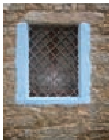
Fig. 3.57. Finestra a due ante con architrave lapideo.
