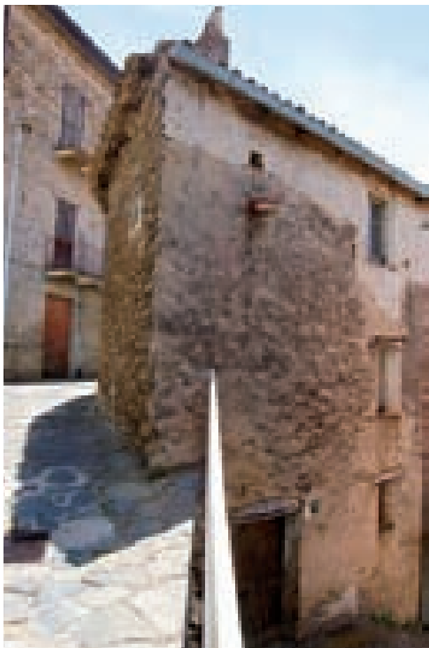
Figg. 2.2, 2.3. Rapporto fra pendio e isolato: cellule abitative a Gavoi e Gadoni realizzate in sostruzione per reggere la spinta della terra tra due strade a quote differenti.
