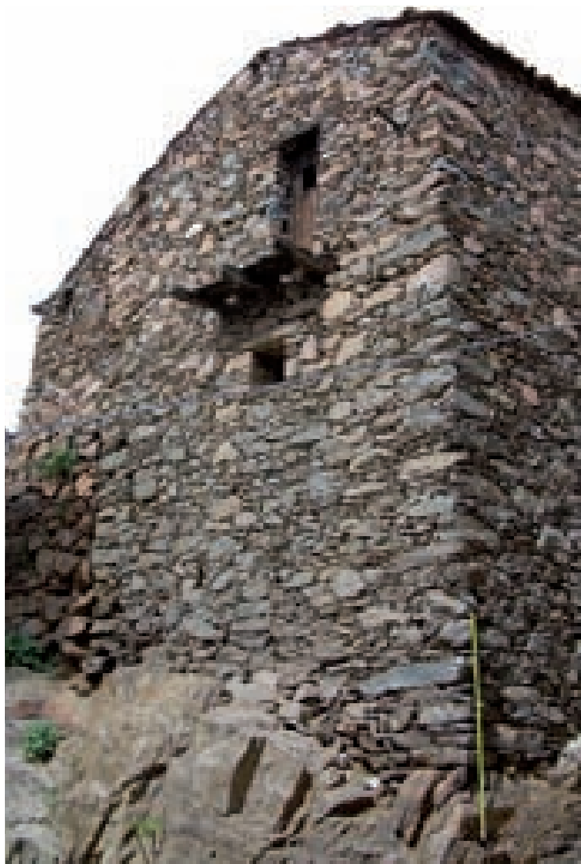
Fig. 3.32. Lode, abitazione tradizionale edificata su basamento naturale roccioso, con murature perimetrali in trovanti di scisto apparecchiati secondo corsi occasionali, con angolata "cucita" con conci allungati e sborgati del medesimo materiale.
