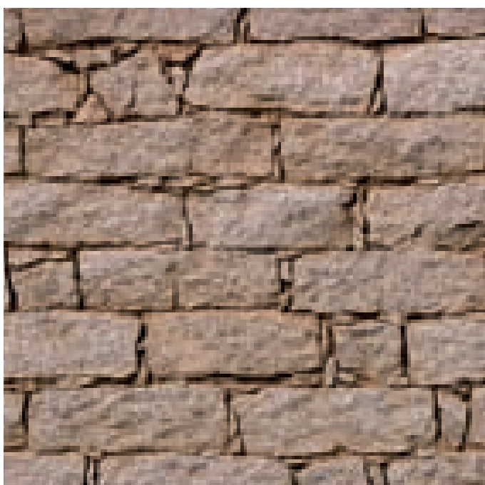
Figg. 3.26, 3.27. Apparecchi murari rilevati ad Ololai e ad Olzai in blocchi grossolanamente squadriati di granito disposti a formare due paramenti paralleli collegati regolarmente da un elemento passante che determina lo spessore totale.
