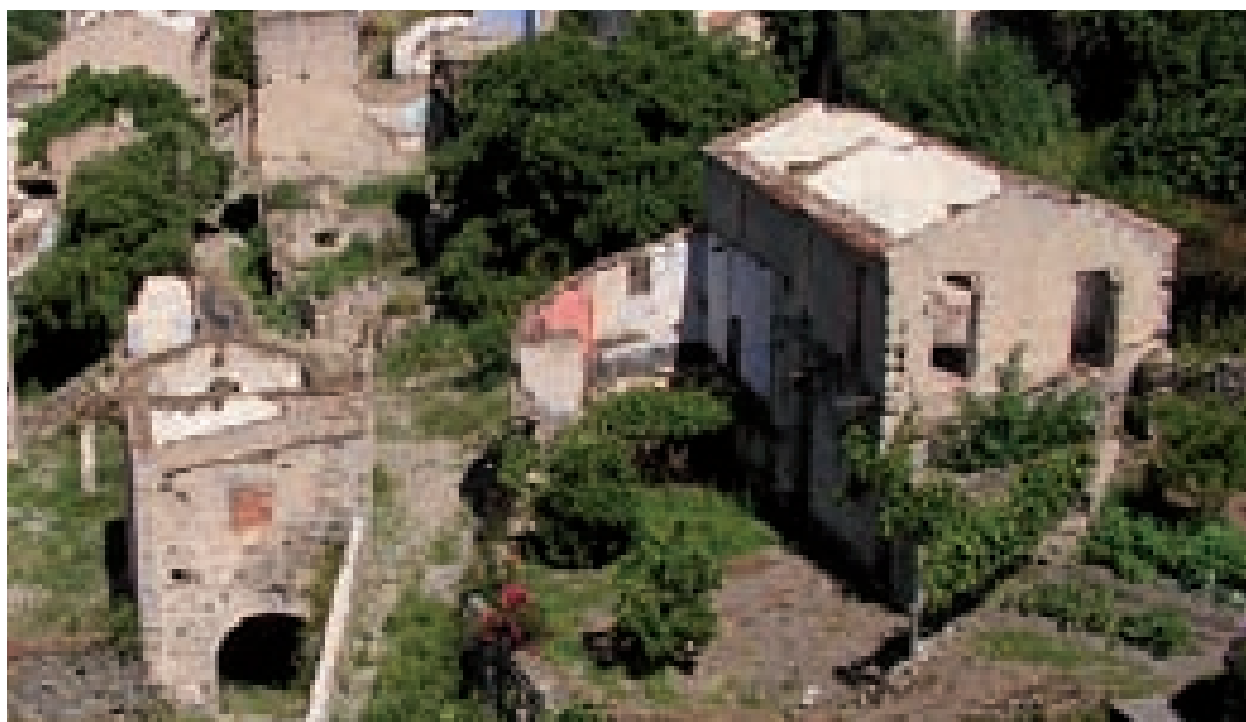
Figg. 3.9, 3.10. Gairo vecchia; esempi di edilizia lapidea a cellule murarie sovrapposte e adiacenti. Nella prima immagine è ben evidente il ruolo portante di una coppia di setti paralleli e quello controventante delle pareti ad essi ortogonali che danno stabilità alla scatola muraria in presenza di eventuali azioni orizzontali. Nella seconda, il crollo degli orizzontamenti mette in evidenza un'edilizia fatta di cellule elementari, alcune delle quali di sostruzione con sistemi voltati di sostegno delle spinte del terreno.
