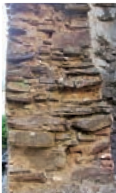
Figg. 3.30, 3.31. Murature in trovanti di scisto appaiecciate secondo corsi occasionali o sub-orizzontali, ingranati tra loro lungo lo spessore murario e stabilizzati mediante malta di terra e rinzeppature lapidee o laterizie (esempi rilevati ad Ussassai e Senù).
