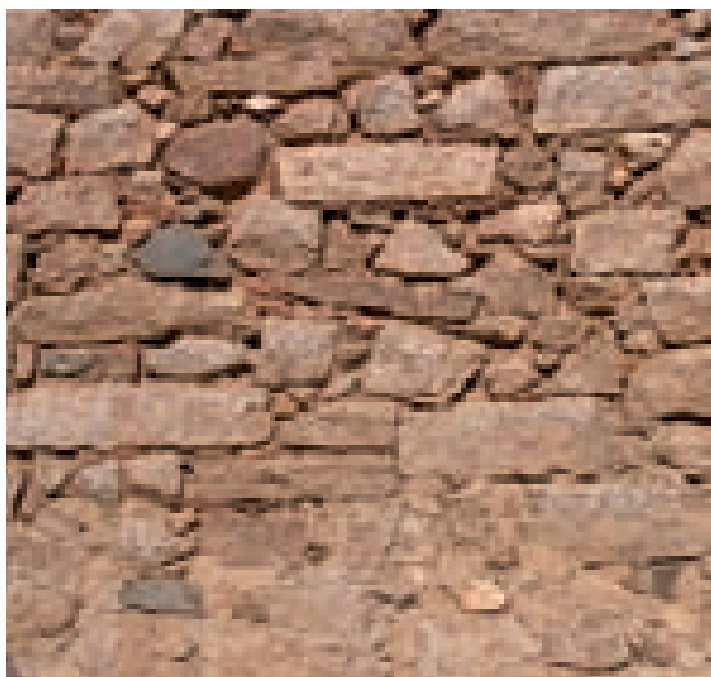
Figg. 3.24, 3.25. Esempi di murature rilevate a Olzai e Lotzorai, eseguite secondo la tecnica muraria che prevede l'edificazione simultanea di due paramenti esterni paralleli, ingranando parzialmente fra loro gli elementi lapidei e stabilizzandoli mediante l'inserimento di diatoni e riempimento dell'intercapedine mediante terra, scaglie lapidee e laterizie.
