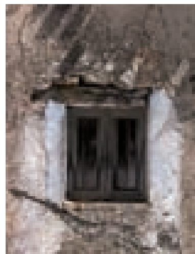
Fig. 3.56. Finestra a due ante con architrave ligneo.
