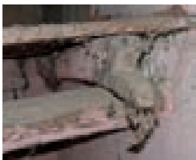
Figg. 3.185, 3.186, 3.187. Dettagli costruttivi dell'interruzione del solaio in corrispondenza della scala; sostegno della trave interrotta mediante: cavallo ligneo, mensola lignea incastrata nella muratura; trave ortogonale.
