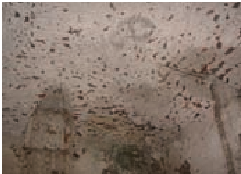
Fig. 3.166. Loculi; volta in pietra a padiglione con lunette laterali. Nella malta è visibile l'impronta della stuoia di canne che completa la centina di sostegno.
