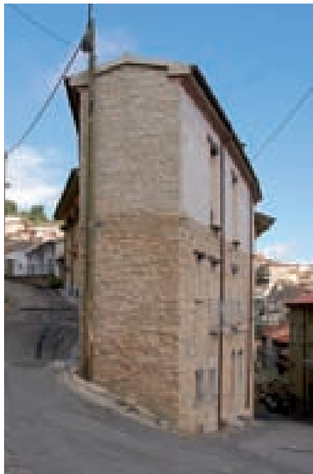
Figg. 2.2, 2.3. Rapporto fra pendio e isolato: cellule abitative a Gavoi e Gadoni realizzate in sostruzione per reggere la spinta della terra tra due strade a quote differenti.
