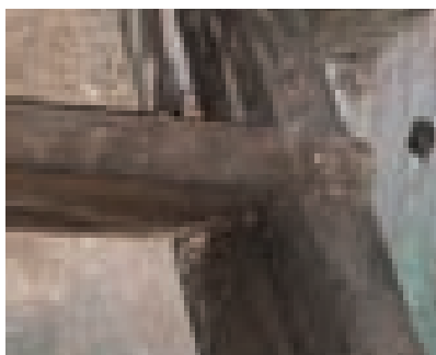
Figg. 3.191, 3.192, 3.193. Dettagli costruttivi della giunzione cosciale - pedata: incastro della pedata dentro asole realizzate nel cosciale; incastro dentro asola più tacchetto d'appoggio; sovrapposizione, al cosciale, di una superficie triangolare in tavola sulla quale vengono chiodate alzata e pedata.
