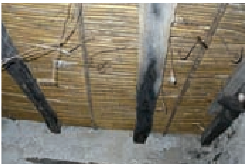
Figg. 3.133, 3.134. Solaio ad orditura semplice e impalcato in canne con canna maestra e soprastante strato di regolazione e ripartizione in terra in due esempi ad Ilbono e a Barisardo.
