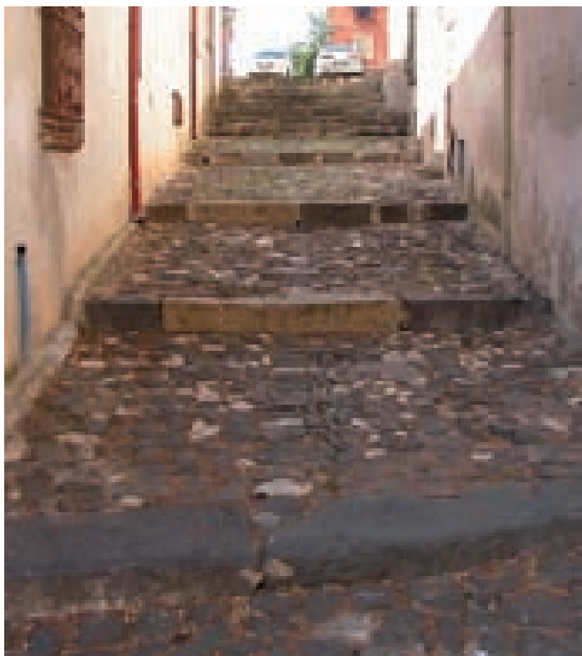
Fig. 3.244. Orosei. Pavimentazione di una gradinata in imperdau in calcare e basalto con compluvio centrale e cordoli in basalto ed elementi di granito provenienti dallo spoglio di altre fabbriche.
