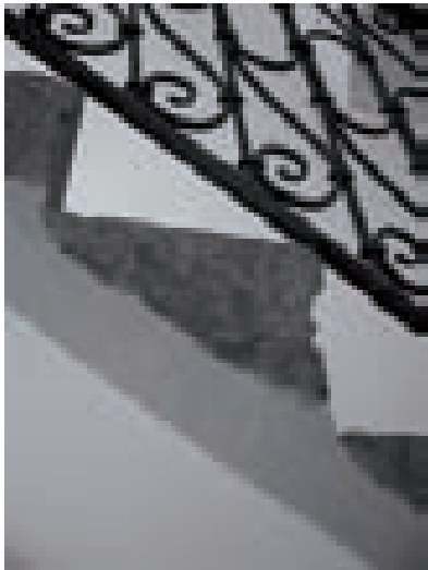
Dettaglio della scala in monoliti di granito
