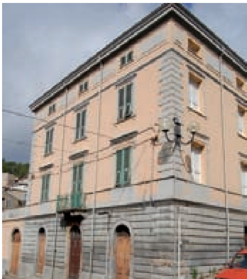
Fig. 2.62. Gavoi, Palazzetto affacciato su strada con corte retrostante. La facciata simmetrica con corpo scala centrale è impreziosita da elementi di decoro quali bugnati, cornici marcapiano e elementi metallici.
