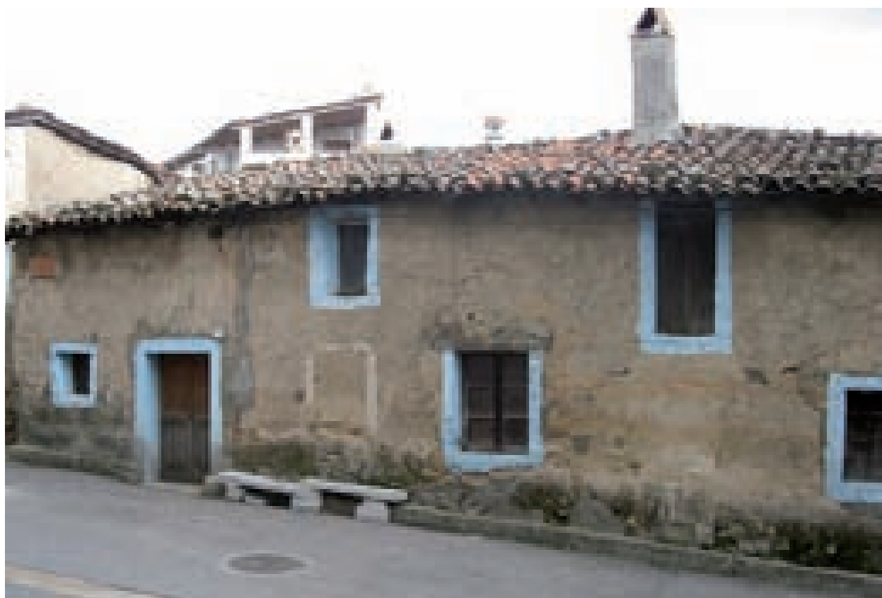
Fig. 2.45. Casa "passante" a Fonni. L'abitazione cresce per affiancamento di cellule su filo strada e in profondità, per saturazione di vuoti urbani o corti minime, dando origine ad un'abitazione con tre cellule su filo strada e due cellule in profondità.
