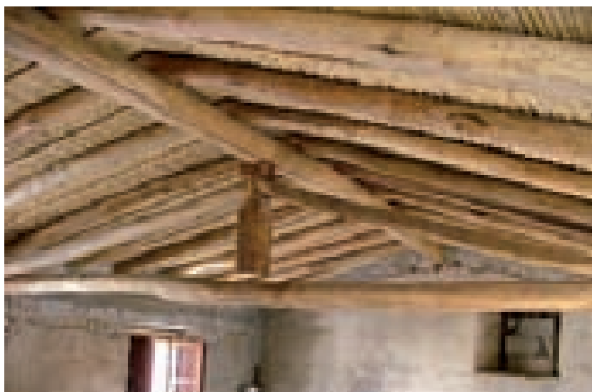
Fig. 3.106. Ilbono; solaio di copertura a due falde a semplice orditura su capriata semplice con monaco, puntoni e catena.
