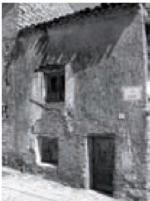
Vista della unità adiacente.
