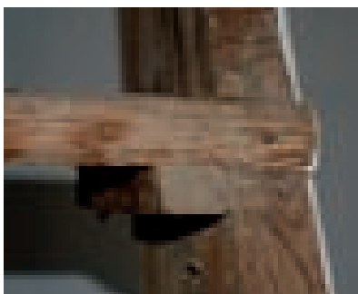
Figg. 3.191, 3.192, 3.193. Dettagli costruttivi della giunzione cosciale - pedata: incastro della pedata dentro asole realizzate nel cosciale; incastro dentro asola più tacchetto d'appoggio; sovrapposizione, al cosciale, di una superficie triangolare in tavola sulla quale vengono chiodate alzata e pedata.
