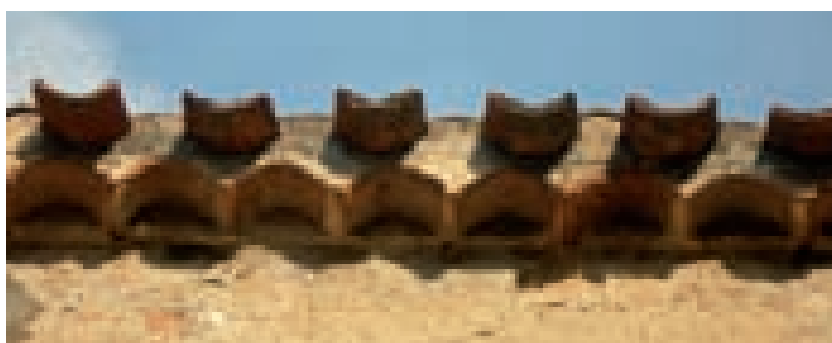
Fig. 3.123. Talana; coppi canale sporgenti a partire da un oggetto in tavole parallele alla linea di gronda sorrette da palombelli lignei incastrati alla muratura.
