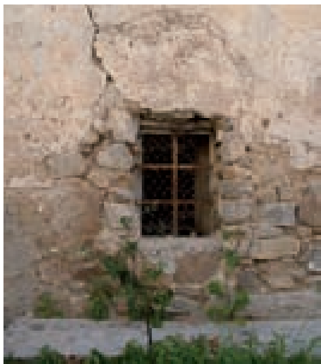
Fig. 4.11. Cedimenti nei muri con aperture allineate che producono dei percorsi di minore resistenza. Oliena.
