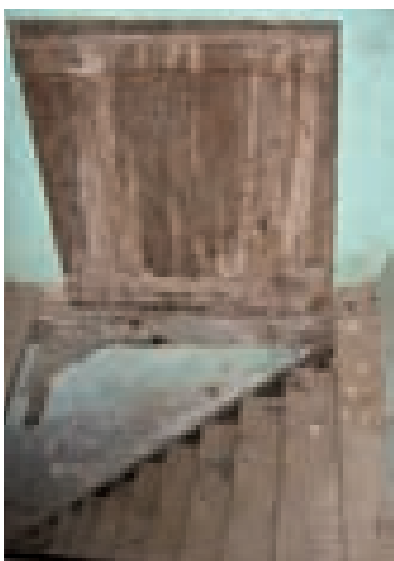
Figg. 3.194, 3.195, 3.196. Esempi di varco nel solaio in corrispondenza della scala: botola vista da sotto; botola vista da sopra; parapetto a protezione del foro della scala: si notino i montanti sagomati a "balanstri piatti".
