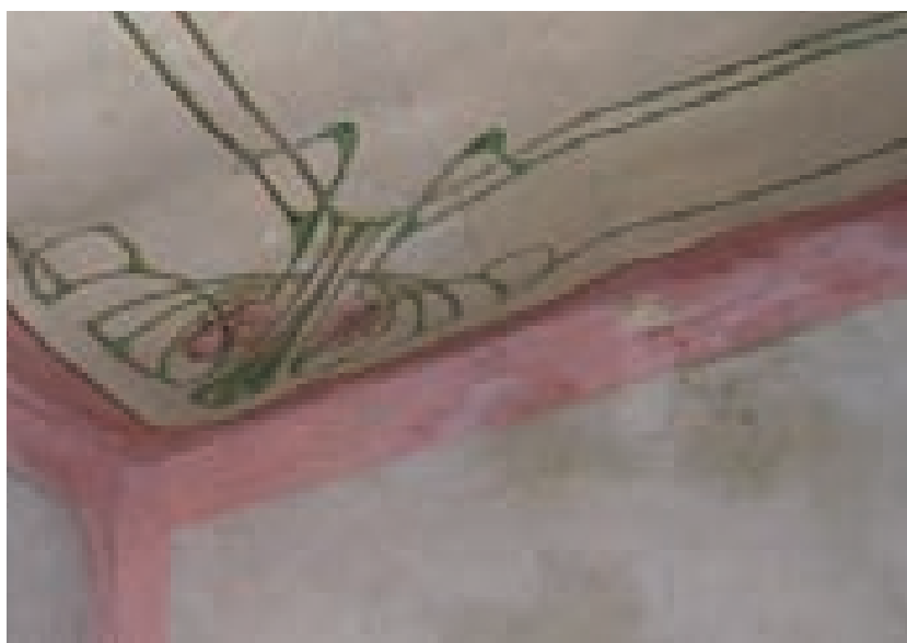
Fig. 3.135. Oliena; intradosso con controsoffitto in tessuto dipinto appeso ad una struttura lignea.
