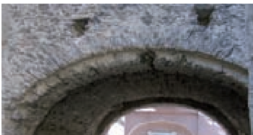
Fig. 3.148. Orosei; volta a botte realizzata in elementi lapidei. Gli archi di rinforzo, arretrati rispetto al filo esterno del muro, assumono una connotazione decorativa.
