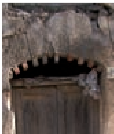
B2 Rottura a taglio Lo spostamento degli appoggi, anche se minimo, produce lo scorrimento dei conci centrali e poi di quelli laterali
