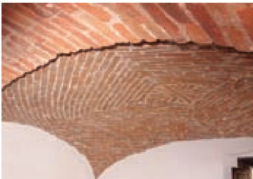
Fig. 3.153. Orosei; volta a vela in laterizi di coltello, con giaciture inclinate di 45° rispetto alle generatrici della volta e chiusa con mattoni riposti a raggiera.
