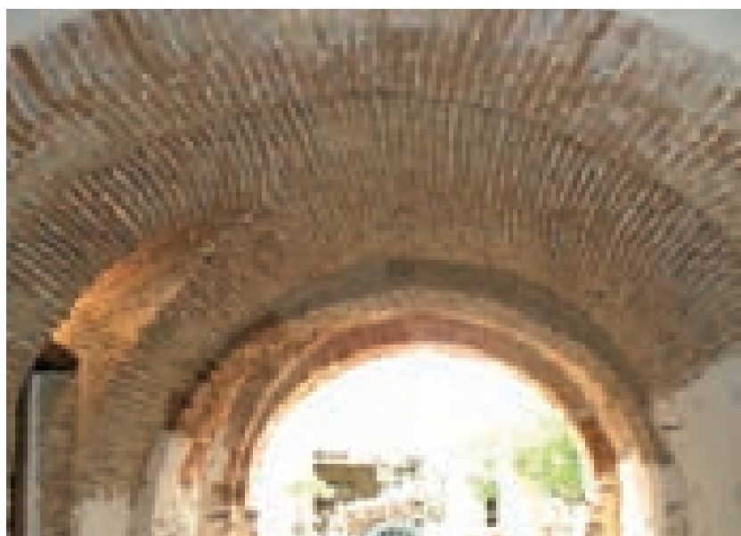
Fig. 3.142. Galtelli; su porziu introduce alla corte dell'abitazione. La copertura è realizzata mediante volta a botte in filari di laterizi disposti a giunti sfalsati parallelamente alla generatrice. Si notino gli arconi che sporgono dall'intradosso della volta in corrispondenza dei setti portanti delle cellule dei piani superiori.
