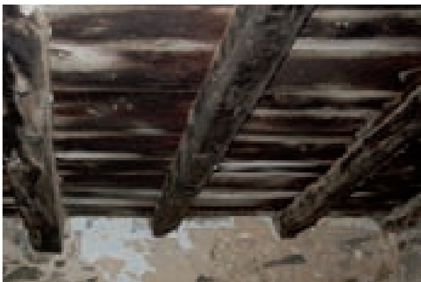
Figg. 3.129, 3.130. Solaio ad orditura semplice con impalcato in tavole in due esempi di Oliena e Ilbono.
