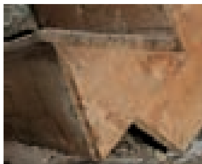
Figg. 3.191, 3.192, 3.193. Dettagli costruttivi della giunzione cosciale - pedata: incastro della pedata dentro asole realizzate nel cosciale; incastro dentro asola più tacchetto d'appoggio; sovrapposizione, al cosciale, di una superficie triangolare in tavola sulla quale vengono chiodate alzata e pedata.
