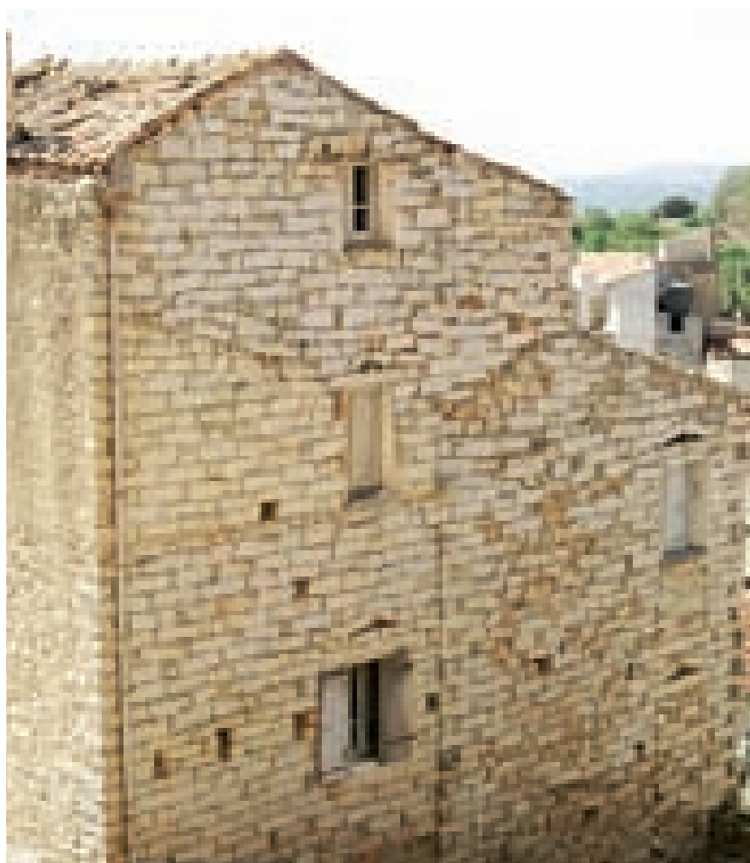
Fig. 2.45. Casa "passante" a Fonni. L'abitazione cresce per affiancamento di cellule su filo strada e in profondità, per saturazione di vuoti urbani o corti minime, dando origine ad un'abitazione con tre cellule su filo strada e due cellule in profondità.
