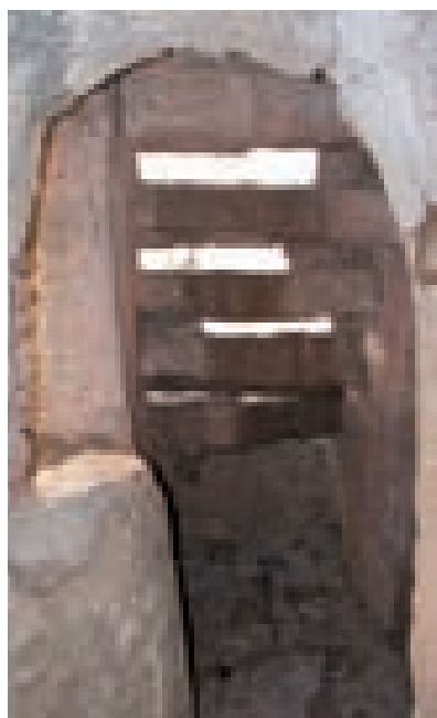
Figg. 3.220, 3.221. Oliena, esempio di scala architravata. Le due foto mostrano l'estradosso e l'intradosso della rampa in monoliti di granito sostenuti da due setti murari. I gradini hanno un'altezza leggermente inferiore all'alzata complessiva, permettendo alla luce di filtrare e illuminare gli ambienti sottostanti, a destinazione rustica. La geometria della scala è condizionata dalla presenza del pozzo dell'acqua.
