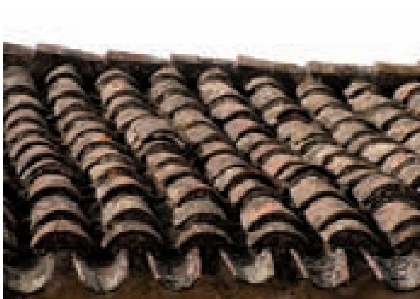
Fig. 3.118. Triei; copertura a due falde contrapposte in coppi sardi.
