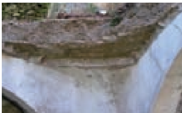
Figg. 3.161, 3.162. Dettagli dei pennacchi di una volta a vela, nei quali si può notare la differente composizione del rinfiacco. Nel primo esempio il rinfiacco è realizzato con pietrame di piccola e media pezzatura e terra sciolta; nel secondo caso il rinfiacco è realizzato quasi totalmente in terra fino allo strato di allettamento.
