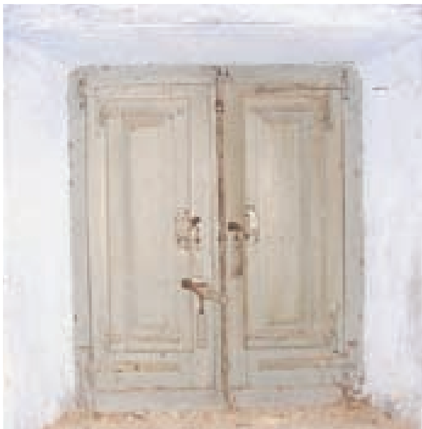
Fig. 3.90. Interno di una finestra a due ante con chiusura a spagnoletta e scurini su ciascuna anta con chiusura a saliscendi.
