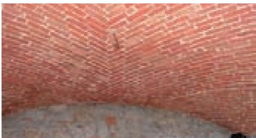
Fig. 3.149. Lanusei; Volta a botte in laterizi disposti a 45°, convergenti lungo la linea di chiave.
