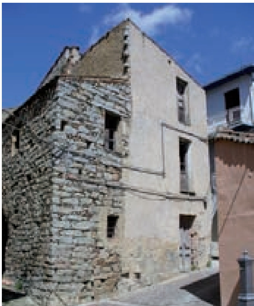
Fig. 2.29. Modalità di affiancamento di due unità abitative a Ilbono: le abitazioni si sviluppano per accostamento di cellule in altezza e in profondità. La presenza di "morse" che sporgono dal cantonale sono indice della consapevole intenzione di raddoppi futuri delle cellule abitative.
