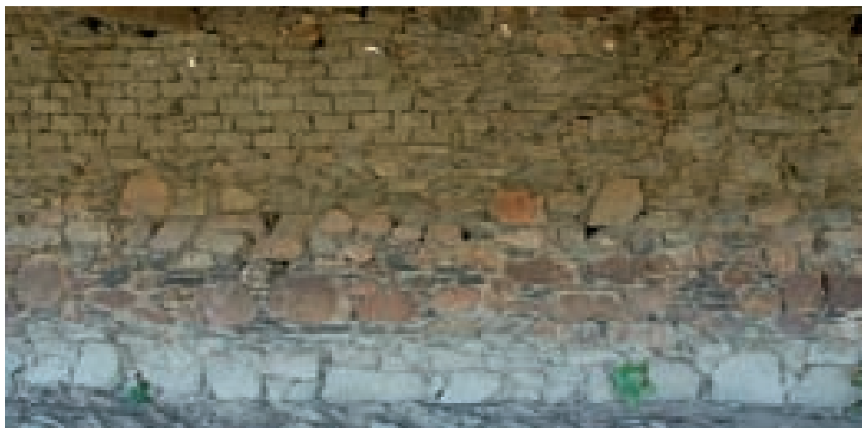
Fig. 3.36. Su de Is Seis, Teulada. Commistione di tecniche murarie all'interno di un unico paramento.
