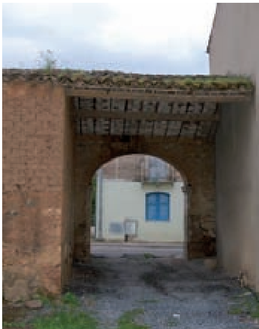
Fig. 3.50. Nuxis. Vista interna del portale. Schema ad arco a tre centri realizzato in laterizi.
