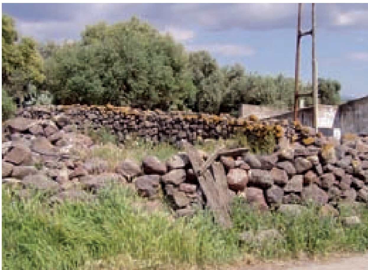
Figg. 3.18, 3.19. Muratura a secco con trovanti piroclastici, Teulada. La stessa tipologia di muratura utilizzata per un recinto arcaico a Is Lais (Masainas).
