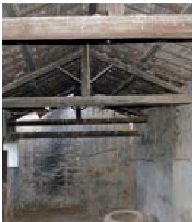
Fig. 3.67, 3.68. Diversi sistemi di copertura di cellula muraria rettangolare. A sinistra, sistema semplice con travi di colmo ed arcarecci, Masainas; a destra, sistema con capriate a Is Pittaus, Nuxis.
