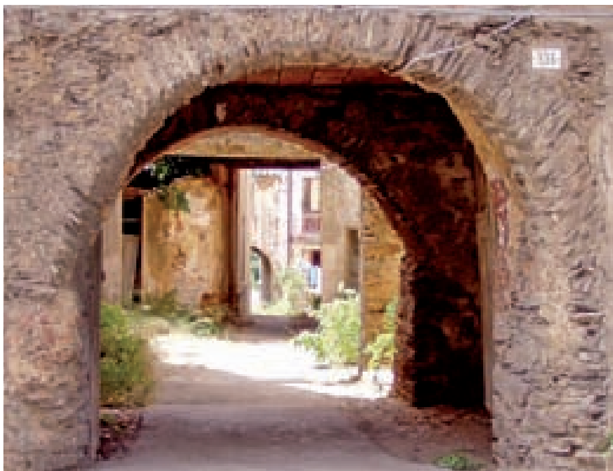
Fig. 3.52. Masainas. Vista interna del portale con arco a tre centri.
