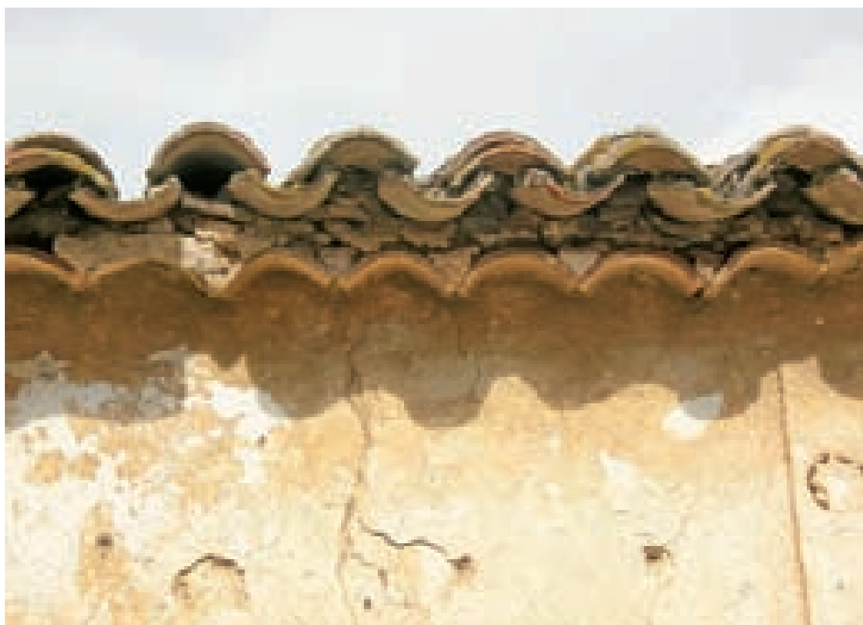
Fig. 4.31. Particolare del nodo di gronda. Medau Is Langius, Santadi.
