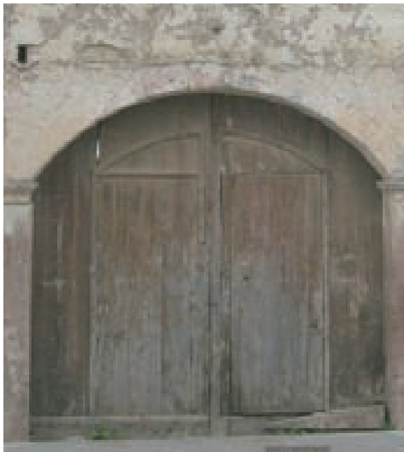
Fig. 3.56. Giba. Portale a sesto ribassato con ingresso carraio realizzato in tavole di pino.
