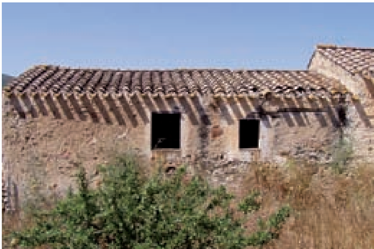
Fig 3.77. Is Carillus, Tenlada. Attacco di gronda con aggetto semplice dei coppi canale.
