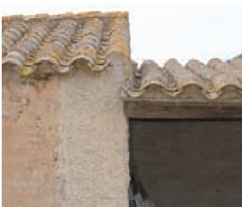
Fig. 4.25. Particolare della copertura del Medau Acqua Cadda, Santadi.
