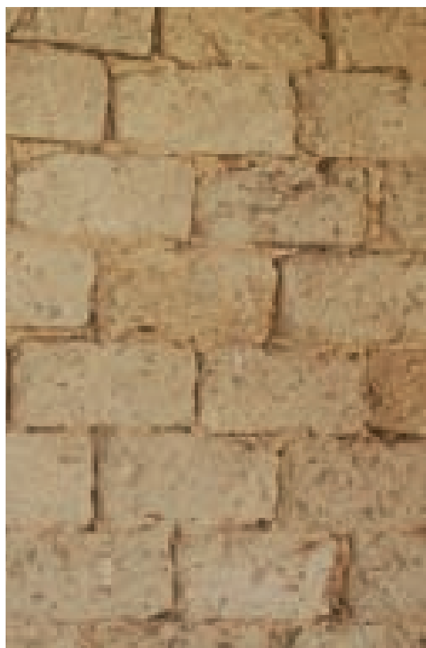
Figg. 3.7, 3.8. Murature in mattoni di terra cruda di diverse dimensioni, granulometria e consistenza, appa-recchiati in chiave su basamento lapideo, in due esempi di Teulada e Narcao.
