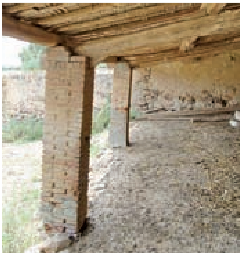
Fig. 3.54. Teulada. Loggiato realizzato con pilastri in mattoni cotti a tre teste.
