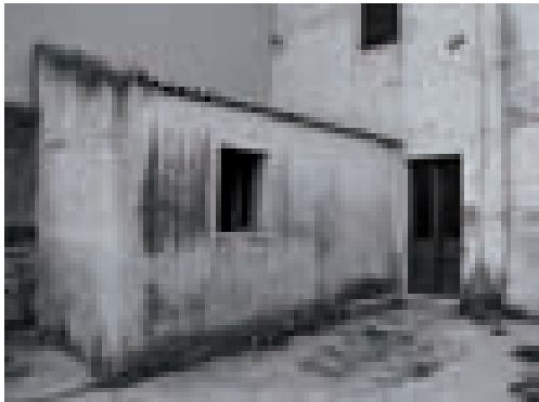
Vista del rustico laterale a sinistra.
