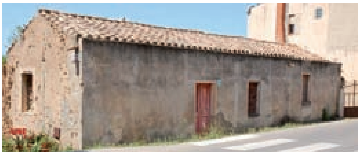
Figg. 3.82, 3.83. Edifici con muro d'attico e gronda interna. Nel primo caso il muro d'attico si sviluppa per tutta la lunghezza del prospetto su strada, S. Anna Arresi; nel secondo il muretto d'attico viene realizzato parzialmente in corrispondenza dell'accesso principale, Sirri, Carbonia.
