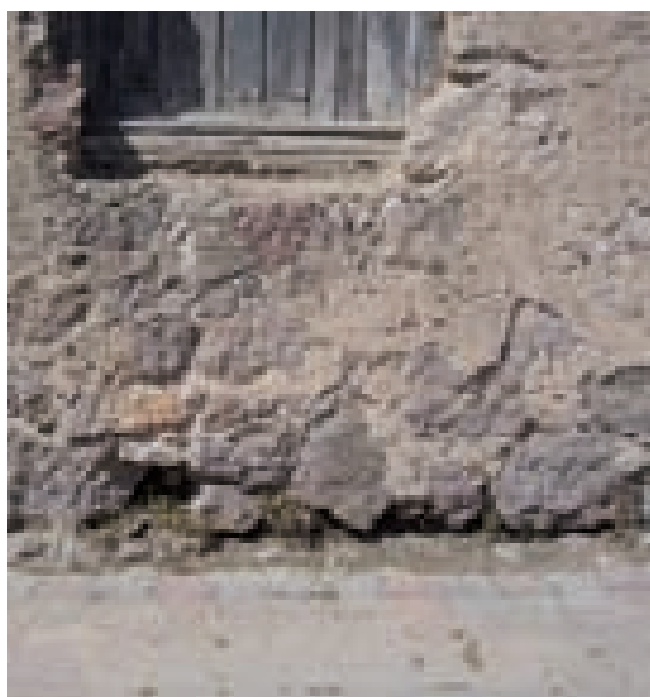
Figg. 3.25, 3.26. Il basamento murario rilevato a Is Cattas (Santadi) abbonda in intonaco di terra, tanto da celare completamente l'apparato lapideo sottostante. A San Giovanni Suergiu con gli stessi trovanti trachitici viene realizzato tanto lo spiccato che il resto della muratura.
