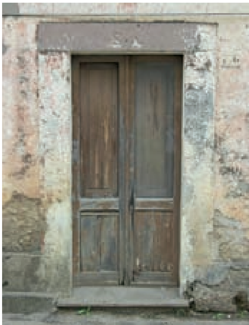
Fig. 3.60. Giba. Porta a due ante con sistema di oscuramento interno.
