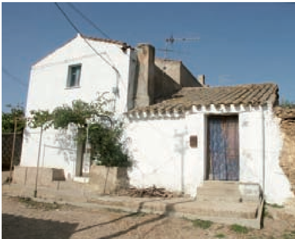
Fig. 2.1. Toulada. Casa a cellule elementari a Sirri.
