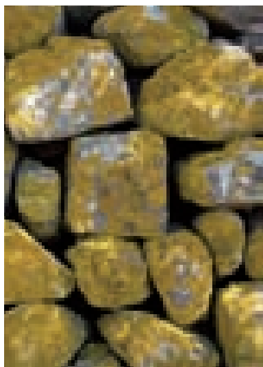
Figg. 3.18, 3.19. Muratura a secco con trovanti piroclastici, Teulada. La stessa tipologia di muratura utilizzata per un recinto arcaico a Is Lais (Masainas).
