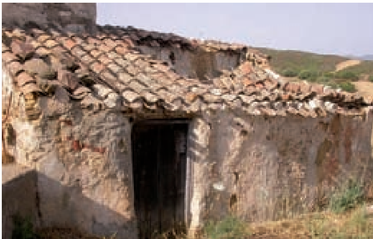
Fig. 4.26. Le coperture. Cedimento della copertura nel Medau Is Cattas, Santadi.
