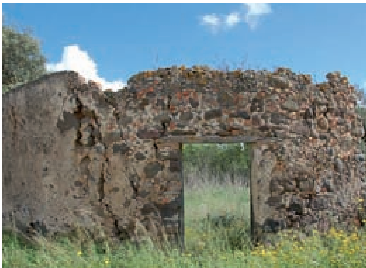
Figg. 3.20, 3.21. Muratura in trovanti piroclastici (trachite) apparecchiata ad opera incerta con malta di calce, Medau Cisella (Tratalias). La stessa tipologia di muratura utilizzata a Coremò, Tratalias.
