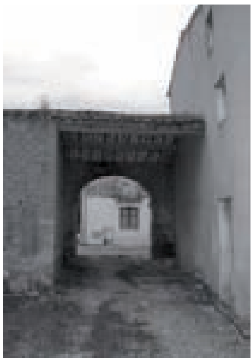
Vista dalla corte verso il portale.
