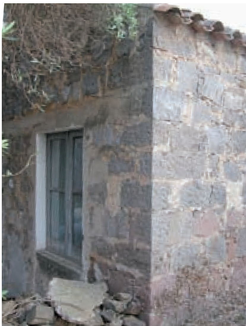
Figg. 3.27, 3.28, 3.29. Particolari del cantonale di murature lapidee. In alto, muratura prevalentemente in conci calcarei con inserimenti trachitici a Giba. In basso, Murature in travanti di scisto apparecchiati secondo corsi occasionali o sub-orizzontali a Is Langius e con blocchi pseudoisodomi in trachite a Is Cattas (Santadi).
