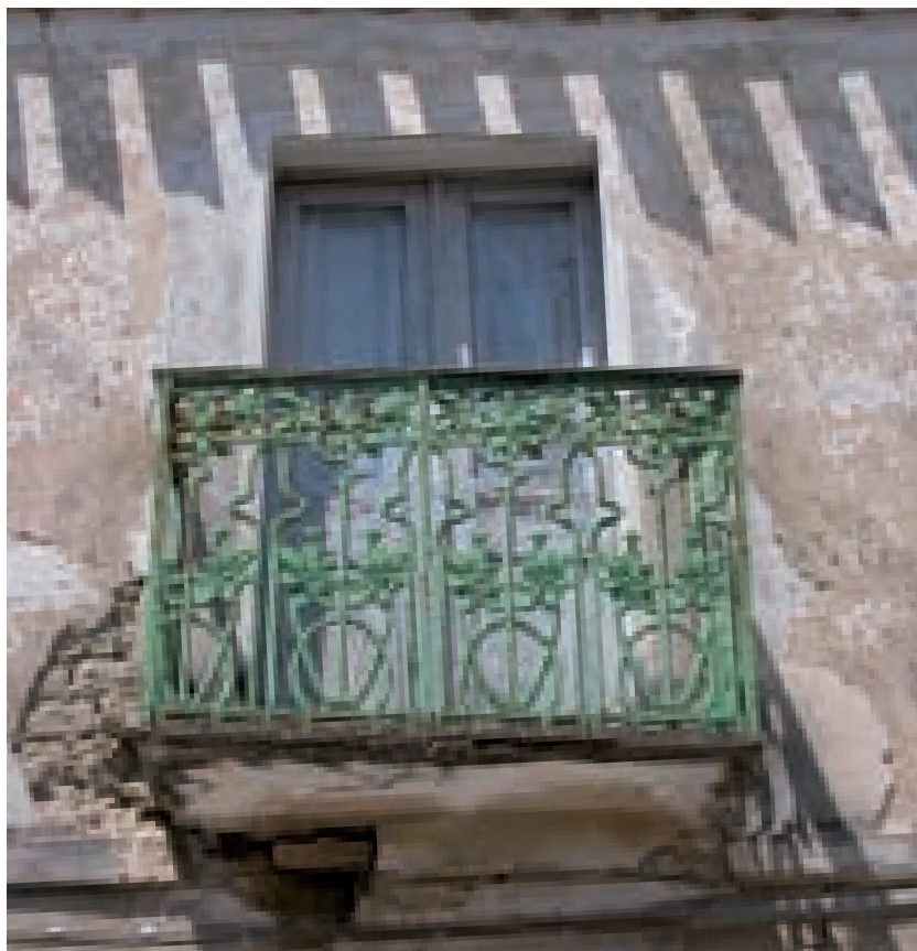
Fig. 4.22. Esempio di balcone a Santadi.
