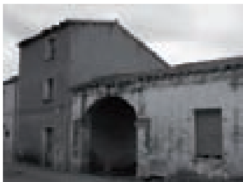
Vista su strada dell'ingresso.
