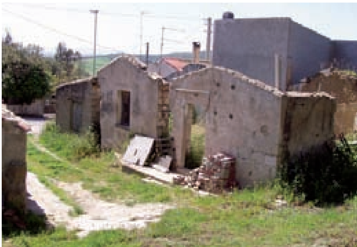
Figg. 3.9, 3.10. Tanì (Iglesias), e Is Gannaus (San Giovanni Suergiu), esempi di edilizia lapidea a cellule murarie sovrapposte e adiacenti. Nella prima immagine lo smantellamento della copertura (caratterizzata dal particolare sistema a due falde adiacenti con gronda in comune) mette in evidenza il sistema costruttivo basato su cellule elementari scatolari. Nella seconda, è ben evidente il ruolo fondamentale dell'arco a tutto sesto, che permette il collegamento tra cellule contigue senza modifiche strutturali del solaio.
