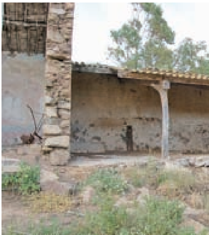
Fig. 3.55. Teulada. Loggiato realizzato con pilastri lignei.
