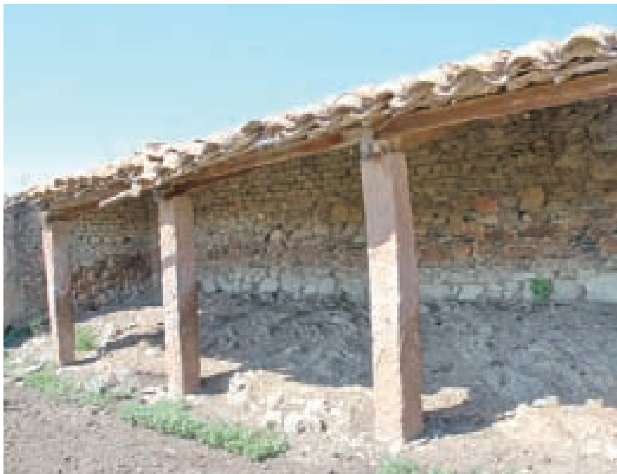
Fig. 3.53. Tenlada, Medau su de Is Seis. Loggiato realizzato con elementi monolitici in pietra.
