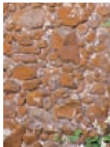
Figg. 3.20, 3.21. Muratura in trovanti piroclastici (trachite) apparecchiata ad opera incerta con malta di calce, Medau Cisella (Tratalias). La stessa tipologia di muratura utilizzata a Coremò, Tratalias.
