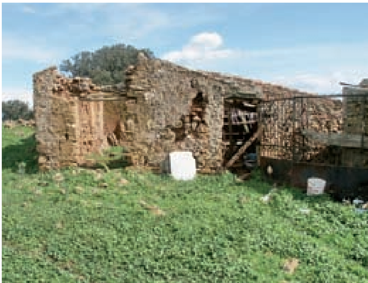
Fig. 4.6. Il degrado della scatola muraria. Degrado di una scatola muraria in elementi lapidei nel Medau Canè, Carbonia.
