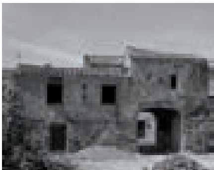
Prospetto sulla corte
