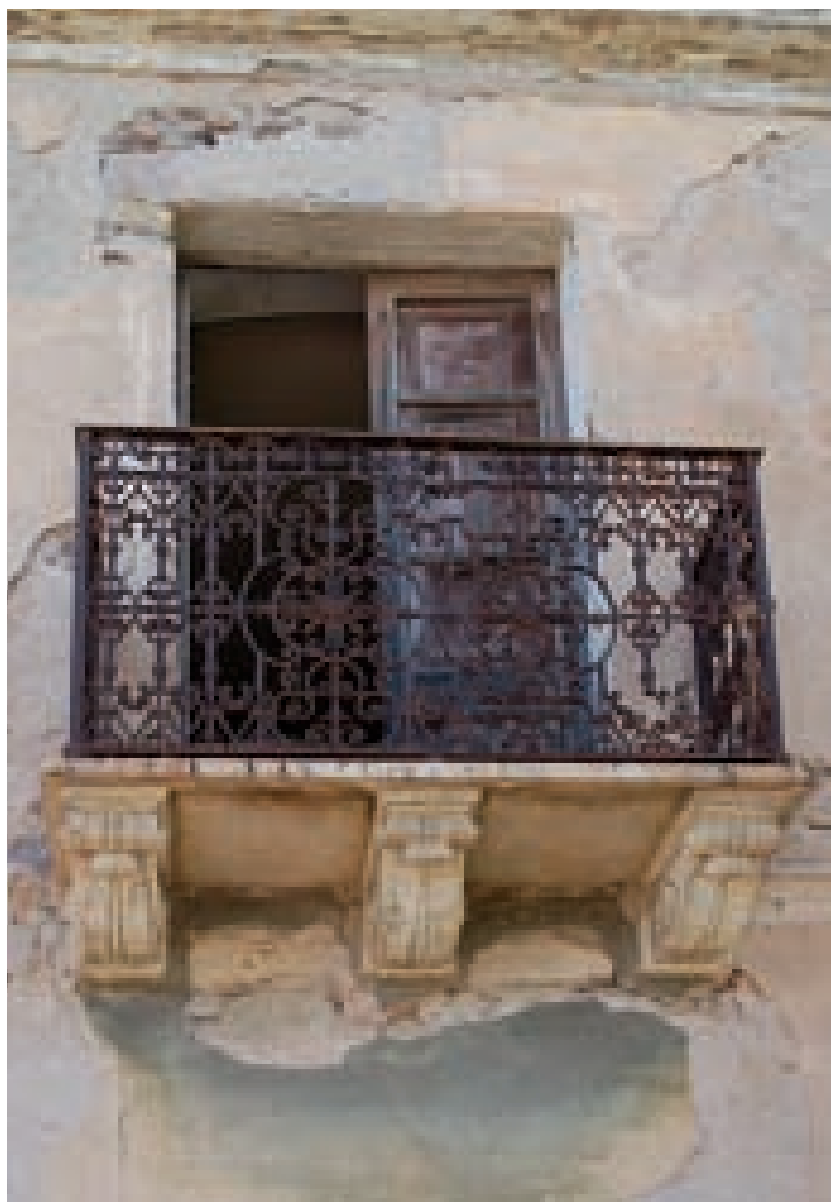
Fig. 3.45. Tratalias. Balcone con parapetto a volute, sorretto da mensole in pietra lavorate.
