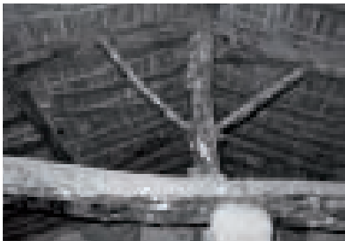
Particolare della capriata.
