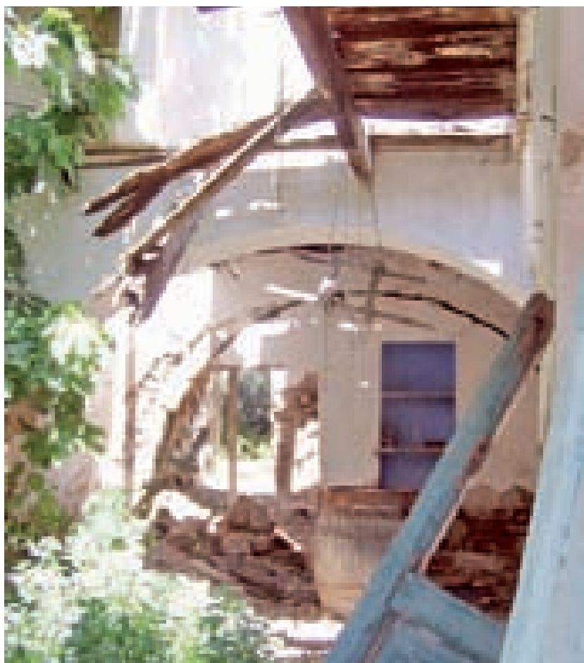
Figg. 3.9, 3.10. Tanì (Iglesias), e Is Gannaus (San Giovanni Suergiu), esempi di edilizia lapidea a cellule murarie sovrapposte e adiacenti. Nella prima immagine lo smantellamento della copertura (caratterizzata dal particolare sistema a due falde adiacenti con gronda in comune) mette in evidenza il sistema costruttivo basato su cellule elementari scatolari. Nella seconda, è ben evidente il ruolo fondamentale dell'arco a tutto sesto, che permette il collegamento tra cellule contigue senza modifiche strutturali del solaio.
