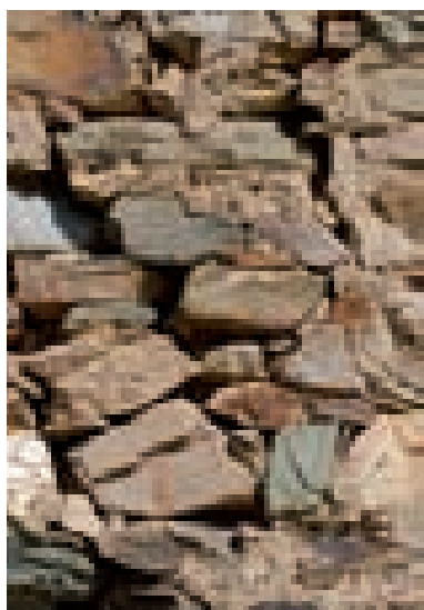
Fig. 3.12. Muratura in scisto, Narcao.
