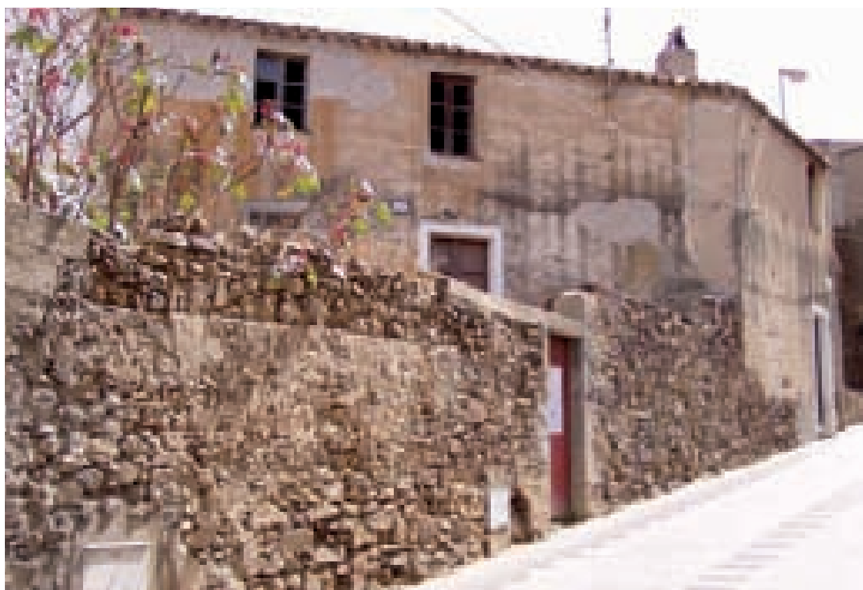
Fig. 3.1. Fluminimaggiore, abitazioni tradizionali in pietra locale (scisto) e terra cruda.
