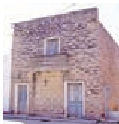
Figg. 3.86, 3.87. Giba. Edifici con muro di coronamento ad occultare il timpano di copertura.
