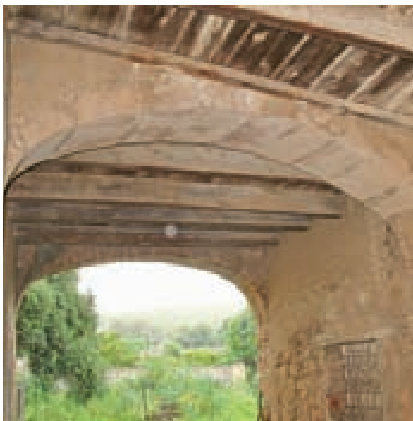
Fig. 3.51. Fluminimaggiore. Archi a tutto sesto e piedritti realizzati in trovanti e scaglie lapidee.
