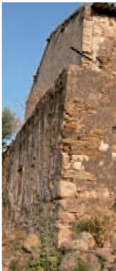
Figg. 3.27, 3.28, 3.29. Particolari del cantonale di murature lapidee. In alto, muratura prevalentemente in conci calcarei con inserimenti trachitici a Giba. In basso, Murature in travanti di scisto apparecchiati secondo corsi occasionali o sub-orizzontali a Is Langius e con blocchi pseudoisodomi in trachite a Is Cattas (Santadi).
