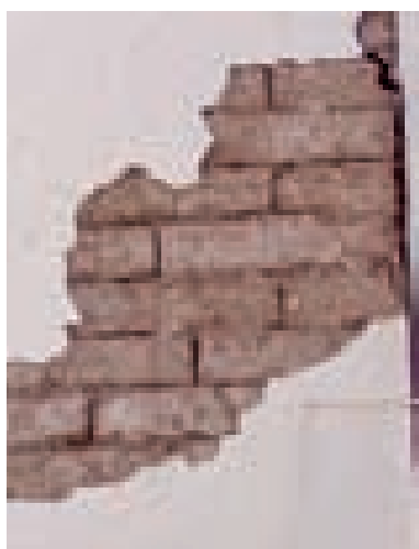
Figg. 3.33, 3.34, 3.35. Struttura intelaiata con montanti in legno, canne ed intonaco in terra, Masainas; elemento murario divisorio in mattoni crudi apparecchiati di fascia, San Giovanni Suergiu; particolare sistema di tamponamento esterno con mattoni in terra cruda apparecchiati di coltello, Narcao.
