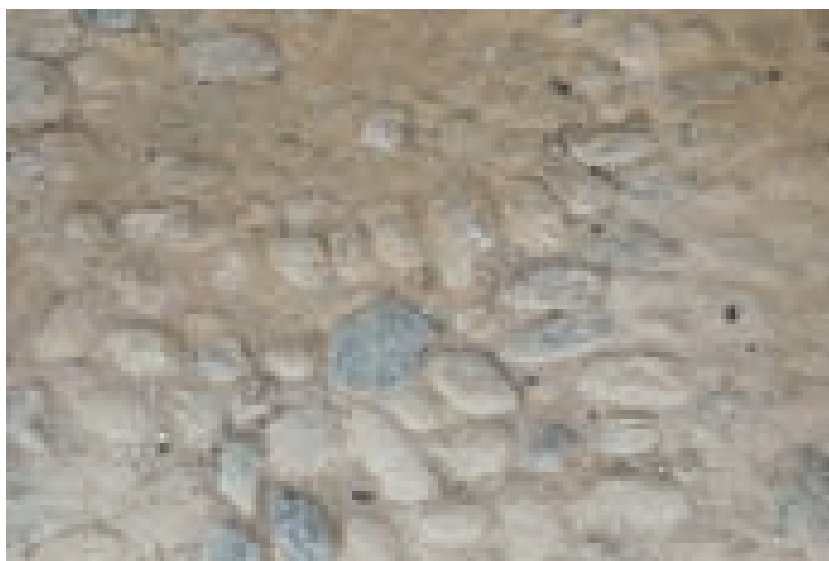
Fig. 3.91. Perdaxius, Medau Pesus. Pavimentazione della corte esterna realizzata in ciottoli.
