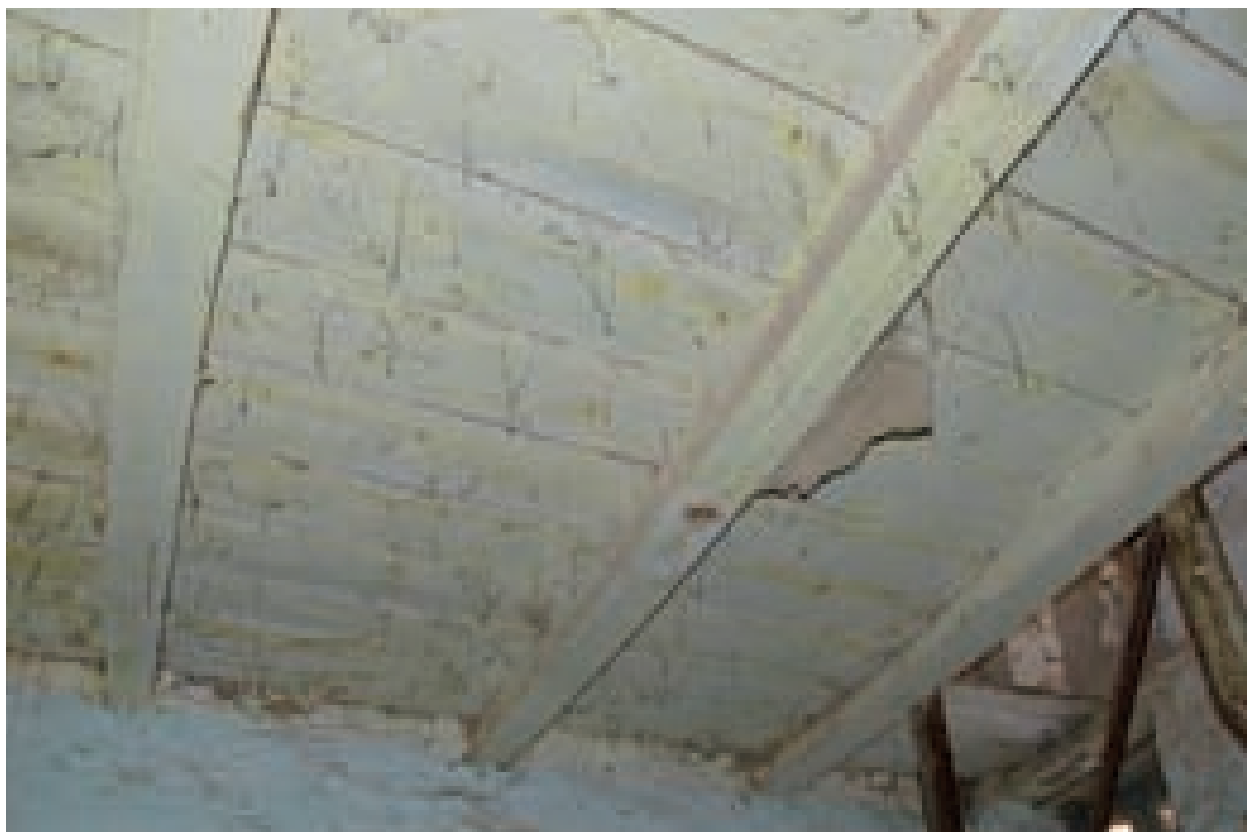
Figg. 4.32, 4.33. Solai lignei a orditura semplice. Estradosso a Nuxis e intradosso a Narcao.
