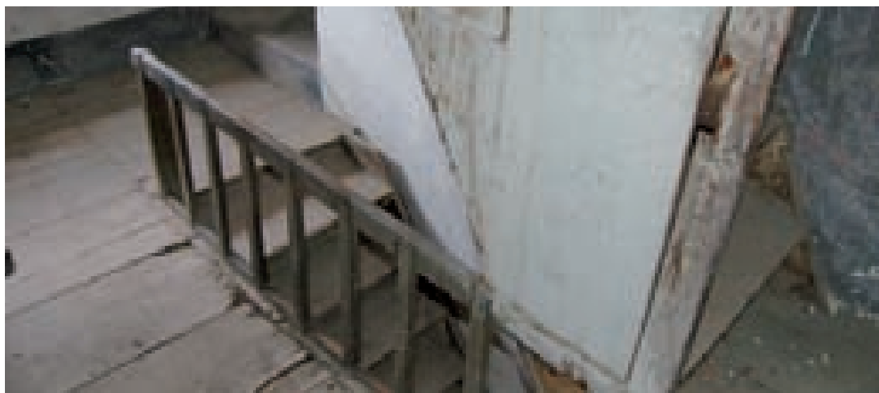
Fig. 3.104. Nuxis. Parapetto con montanti e corrimano lignei.
