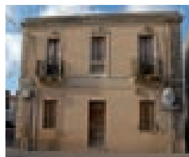
Figg. 3.84, 3.85. Palazzetti urbani con muro d'attico e gronda interna a Narcao e Giba. In entrambi i casi la linea di gronda è parallela al prospetto principale.
