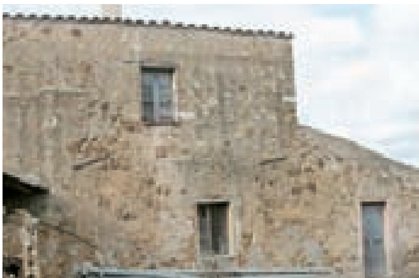
2_ Sistema arcaico con fuoriuscita della trave e paletto ligneo
