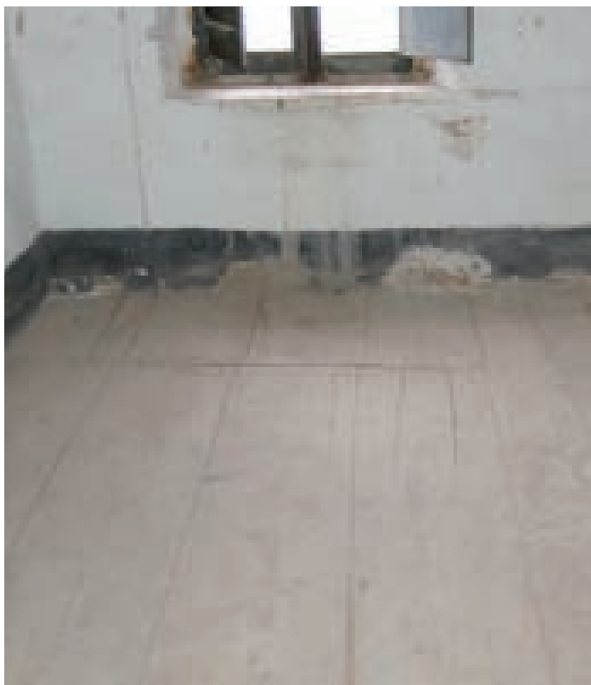
Figg. 4.32, 4.33. Solai lignei a orditura semplice. Estradosso a Nuxis e intradosso a Narcao.
