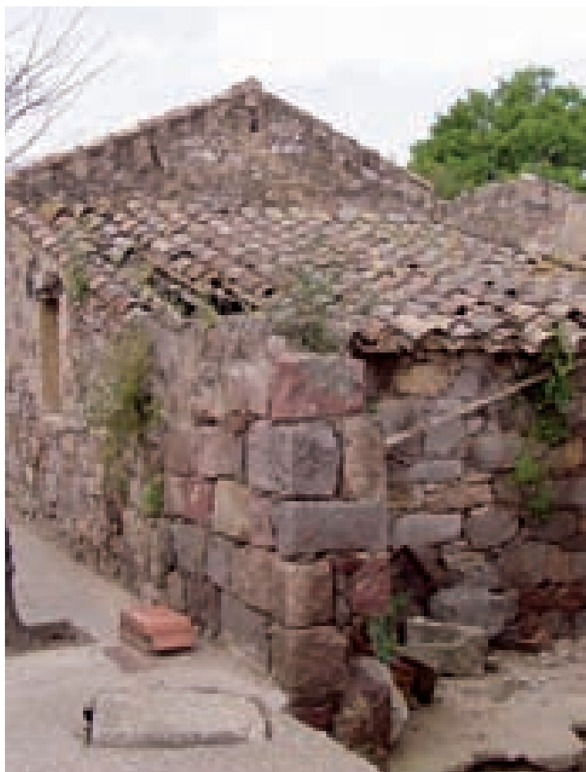
Figg. 3.31, 3.32. Nel primo esempio è leggibile l'estensione laterale su strada del paramento murario realizzata con elementi lapidei e struttura differente rispetto a quelli del corpo originario, Giba; il secondo è caratterizzato da un accostamento dei paramenti murari lapidei senza alcun tipo di ammorsamento, Is Cattas (Santadi).
