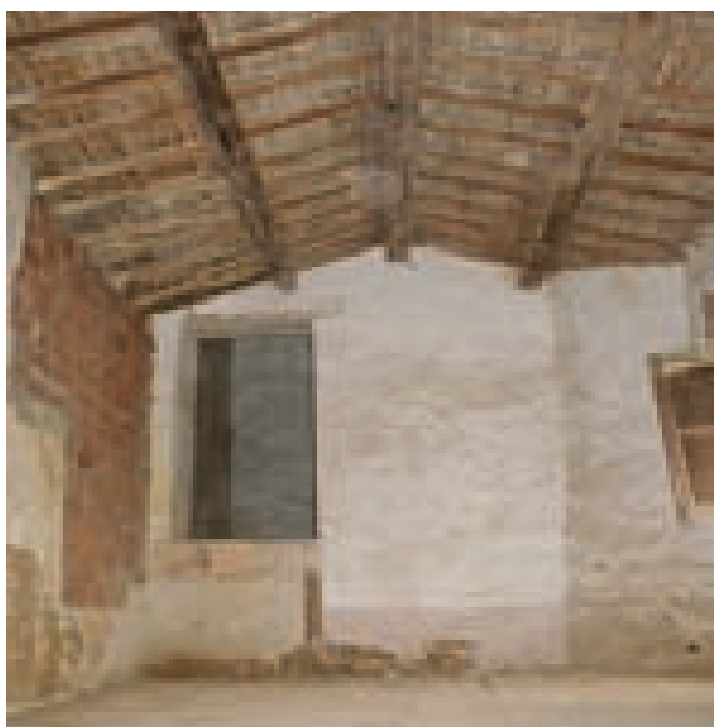
Figg. 3.63, 3.64. Sistemi costruttivi a capanna con trave di colmo, arcarecci e correnti a Masainas e Tenlada.
