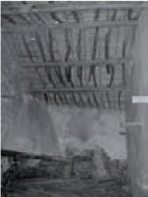
Particolare della copertura con travicelli in ginepro.
