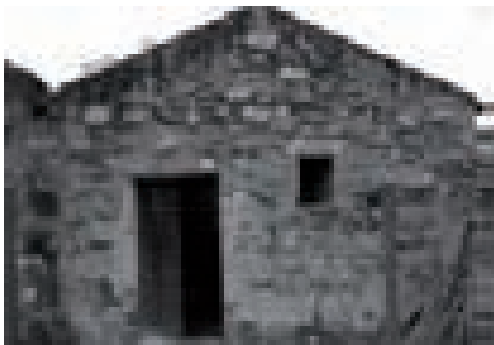
Prospetto sulla corte.
