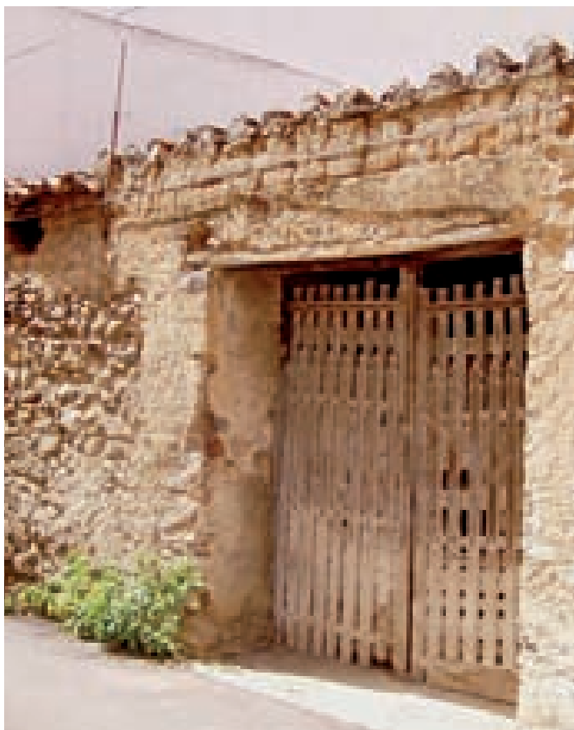
Fig. 3.49. Fluminimaggiore. Portale con architrave realizzato in tronchi lignei di ginepro, olivastro o leccio.
