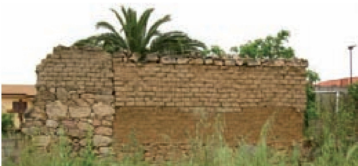
Figg. 3.16, 3.17. Muratura in scisto e mattoni di terra cruda (Fluminimaggiore); muratura in mattoni di terra cruda di differenti tipi su basamento lapideo (Giba).
