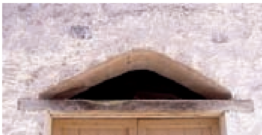
Fig. 3.41. San Giovanni Suergiu, Medau Is Gannaus. Elemento di scarico in conci squadrati lapidei sovrastante l'architrave in legno e spallette in mattoni cotti.
