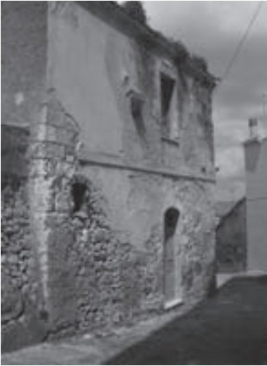
Vista del fronte dell'edificio
