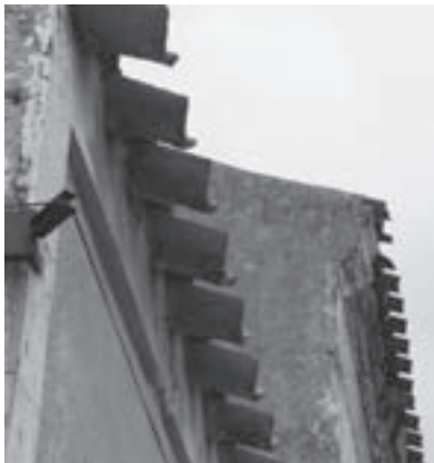
Vista esterna delle soluzioni di gronda
