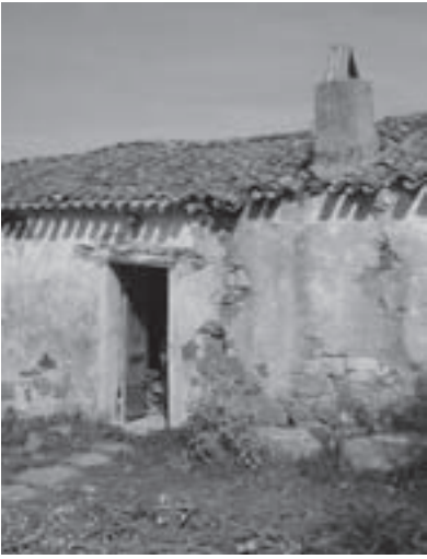
Vista dell'ingresso all'edificio
