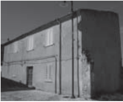
Vista del fronte dell'edificio
