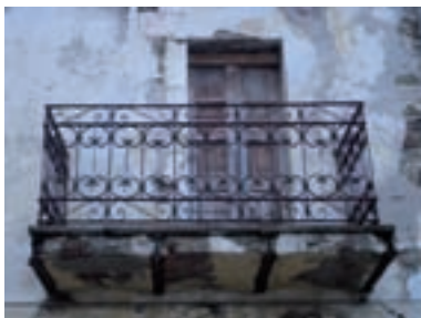
Fig. 3.66. Perfugas; balcone con soletta in putrelle e voltine.
