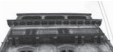
Dettaglio intradosso del balcone
