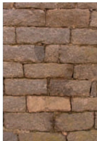
Fig. 3.13. Muratura in granito (Tempio Pausania).
