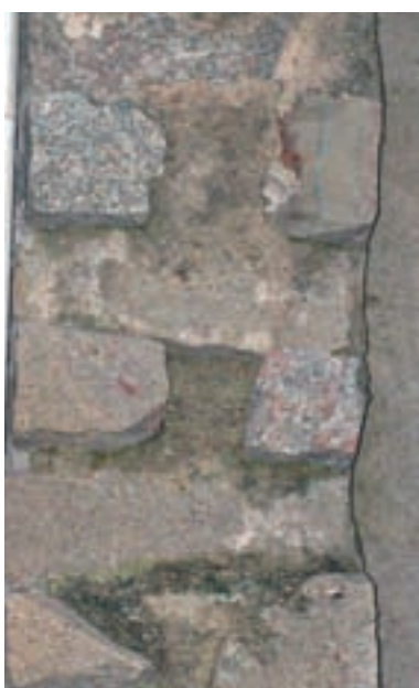
Figg. 3.20, 3.21. Apparecchi murari, rilevati a Calangianus, in blocchi grossolanamente squadrate di granito disposti a formare due paramenti paralleli collegati regolarmente da un elemento passante che ne determina lo spessore.
