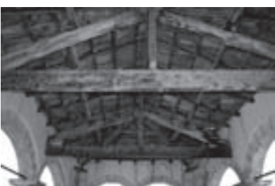
Particolare del sistema di copertura dell'altana
