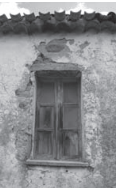
Finestra sul prospetto principale
