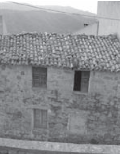
Vista del prospetto retrostante
