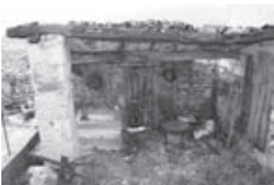
Vista del loggiato rustico nella corte retrostante
