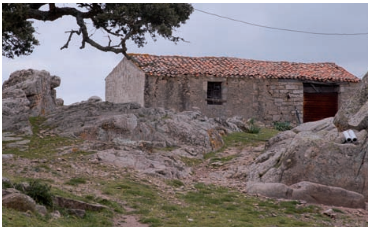
Fig. 2.43. Stazzo realizzato con un'unica cellula coperta con tetto a due falde, a sinistra, con funzioni abitative, e la successiva annessione di una cellula rustica, a destra.
