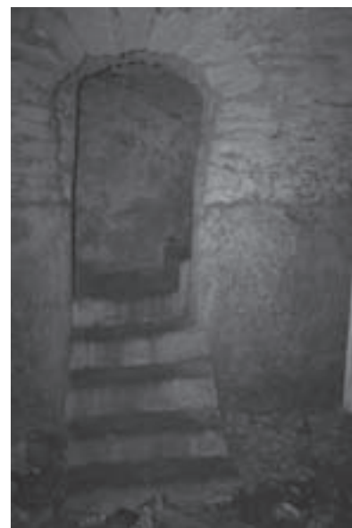
Vista della scala d'accesso al locale interrato
