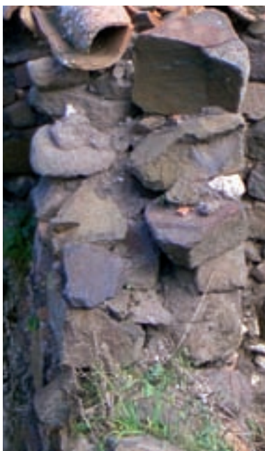
Figg. 3.16, 3.17. Sezione e prospetto di apparecchi murari in trovanti lapidei di varia natura e pezzatura, realizzati senza particolare cura nell'ammorsamento fra i paramenti, stabilizzati con malta di terra e rinzepature con pezzame minuto (Osilo e Thiesi).
