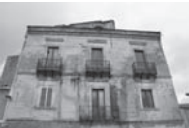
Vista della parte alta del fronte dell'edificio
