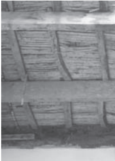
Vista dell'intradosso della copertura
