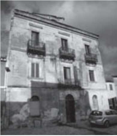
Vista frontale dell'edificio
