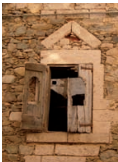
Fig. 3.54. Pattada; finestra a due ante con architrave lapideo sovrastato da un triangolo di scarica.
