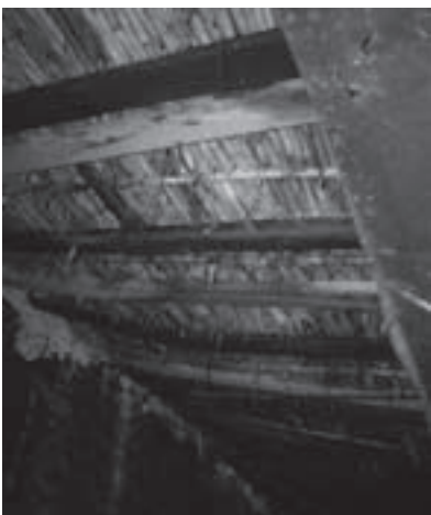
Dettaglio della struttura di copertura lignea
