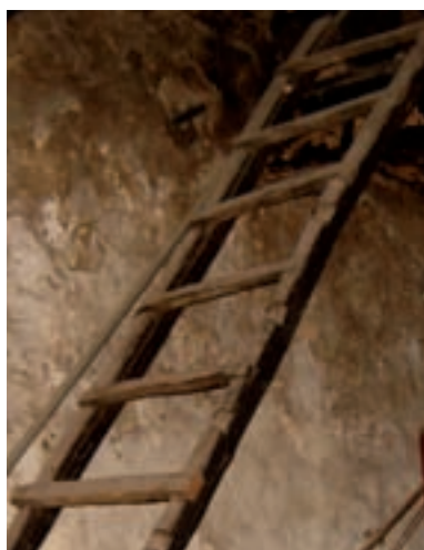
Fig. 3.150. Pattada; scala a pioli lignei per l'accesso al sopralco.
