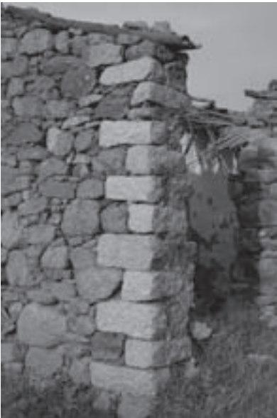
Dettaglio della muratura d'angolo
