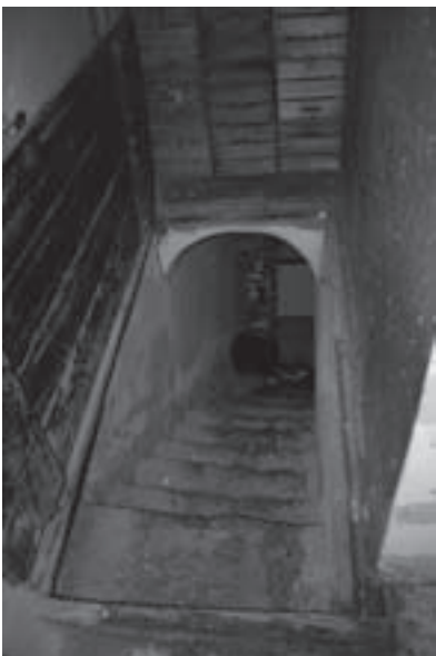
Vista della scala d'accesso al piano seminterrato coperta mediante botola in tavole lignee
