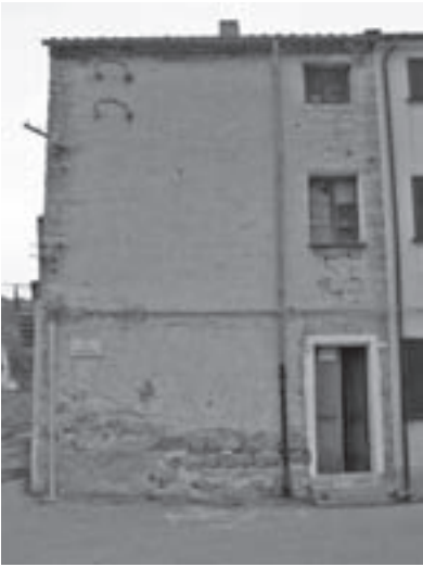
Vista frontale dell'edificio
