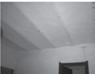
Particolare del solaio in putrelle e voltine
