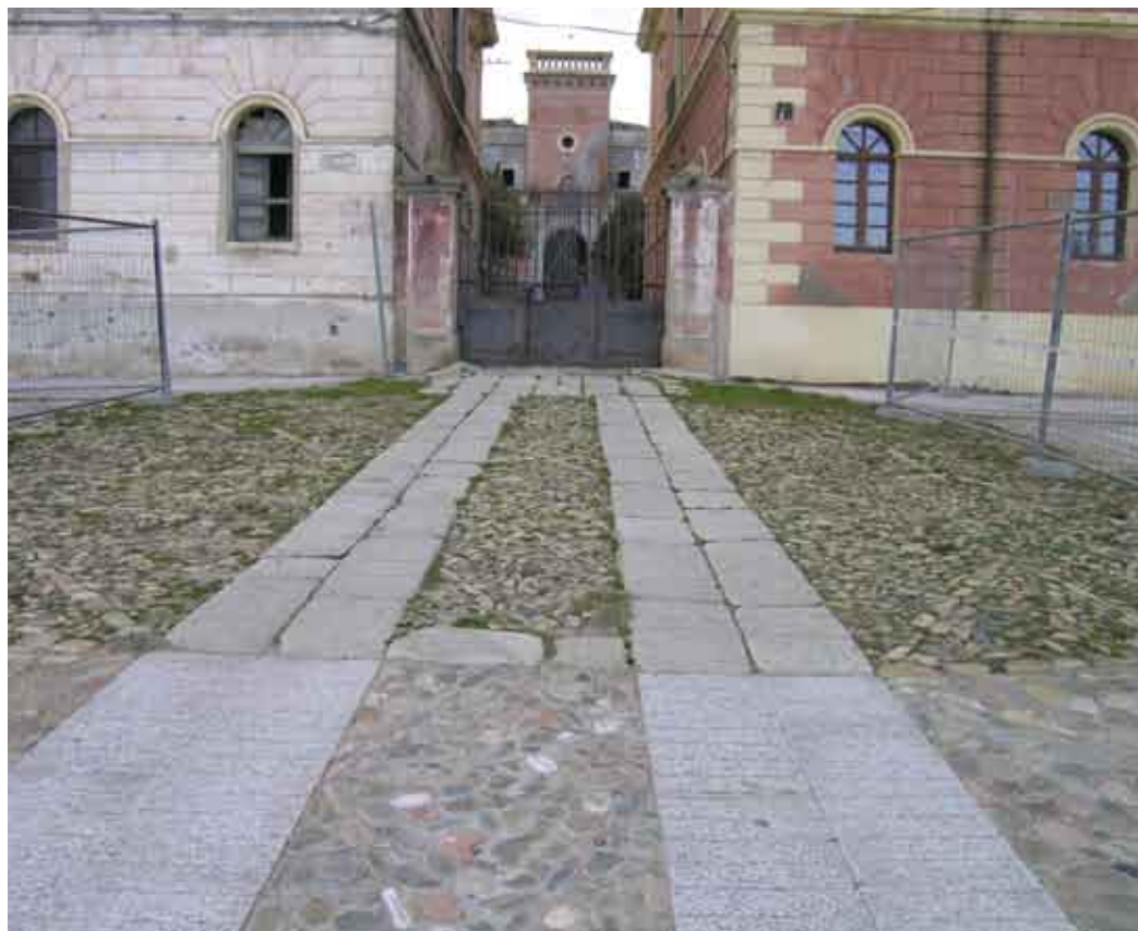
Castiadas. La ripresa di motivi e pavimentazioni originali non deve limitarsi alla semplice imitazione del disegno ma essere capace di riproporre le qualità originarie dei materiali e le loro peculiari lavorazioni superficiali e di posa in opera.
